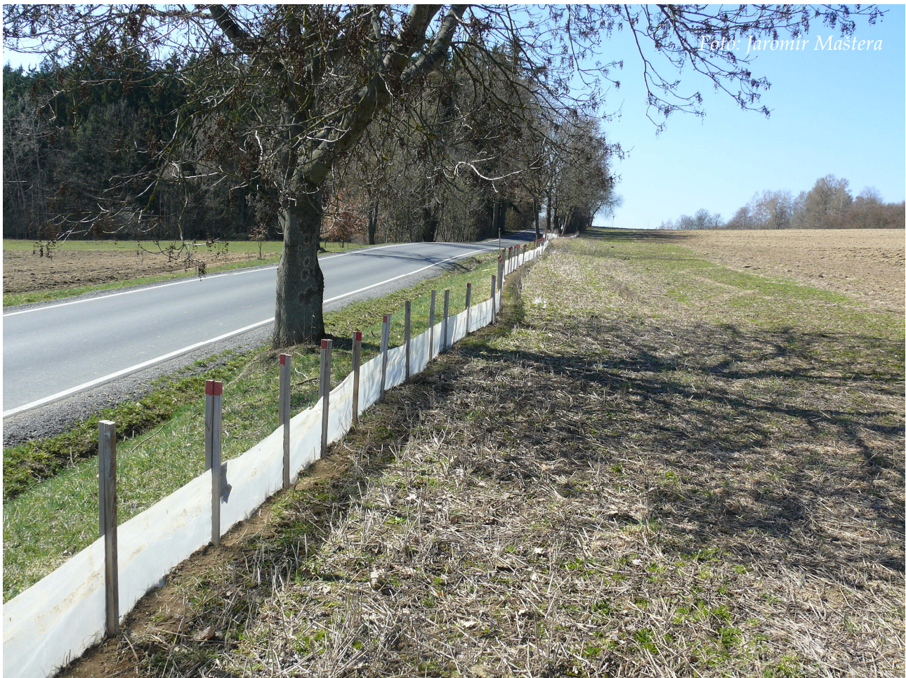
Foto 5: Hotové dočasné zábrany na ochranu obojživelníků u Svitáku (březen 2019)
