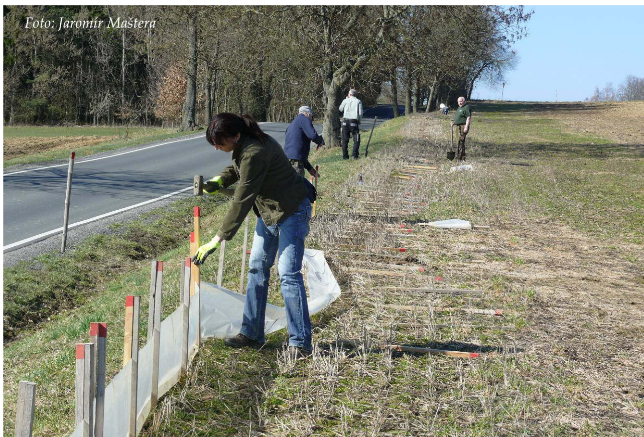
Foto 1: Budování zábran u Svitáku (březen 2019)
