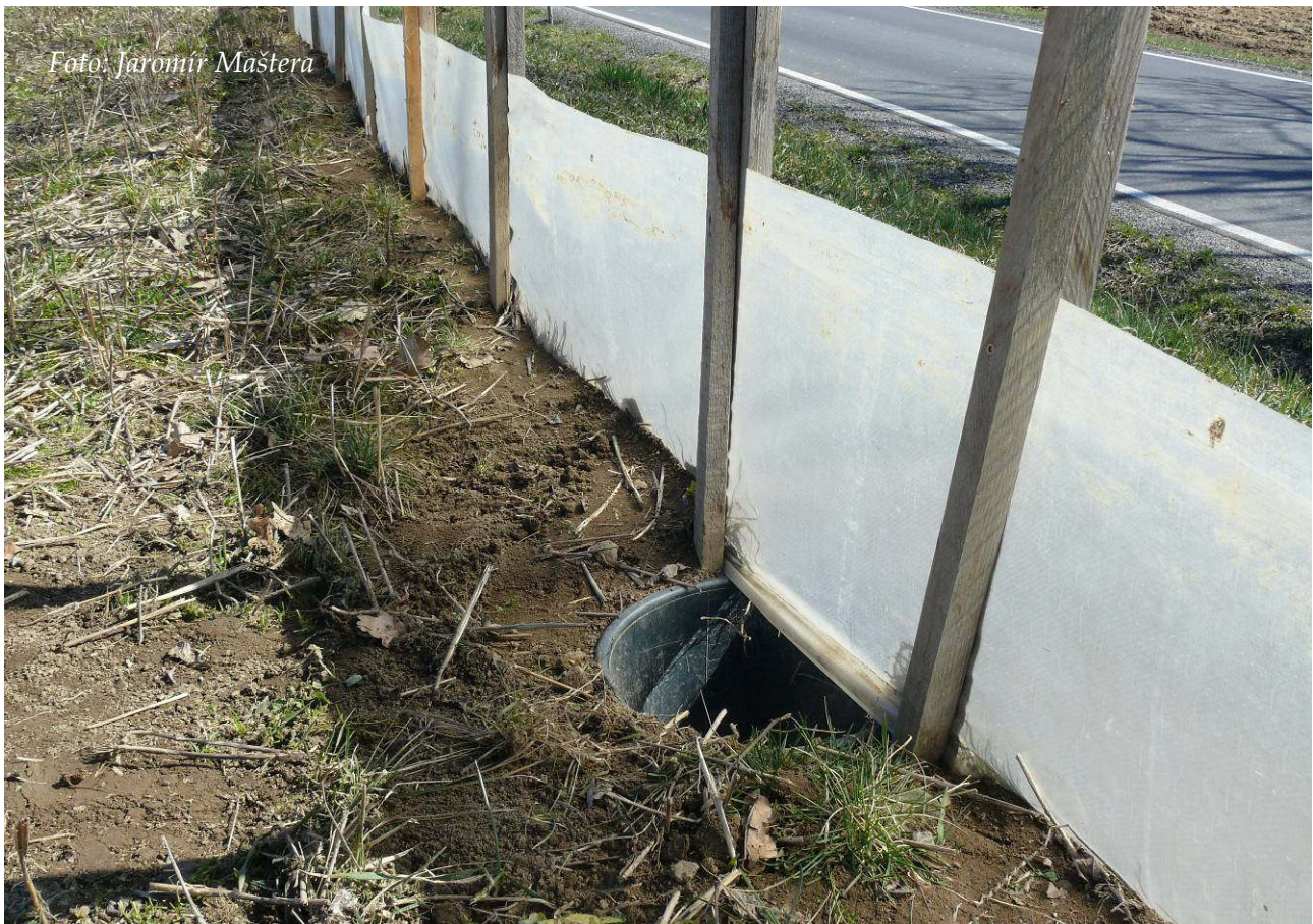
Foto 3: Instalované zábrany u Svitáku – detail s odchytnou nádobou (březen 2019)
