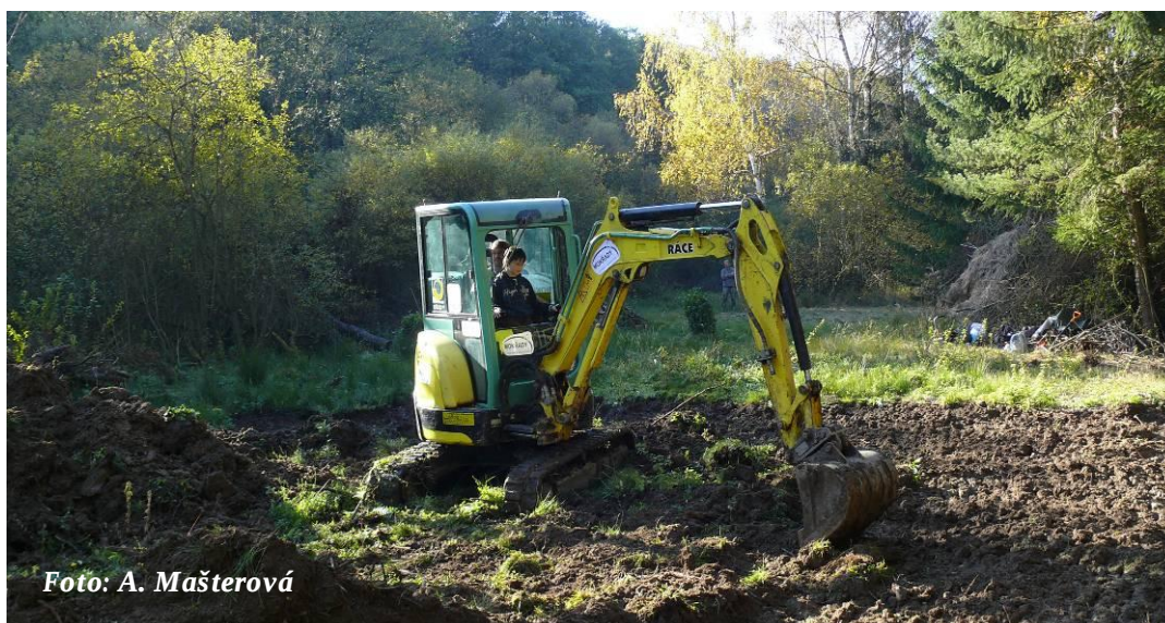
Foto 10: Bagrování tůně pásovým minirypadlem s prvním zájemcem (20.10.2012)
