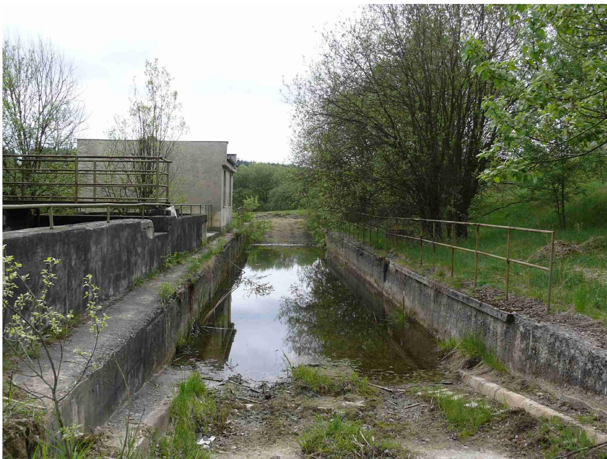
Foto 15: Betonová nádrž na mytí vojenských vozidel, čerstvě pročištěná [květen 2010]
