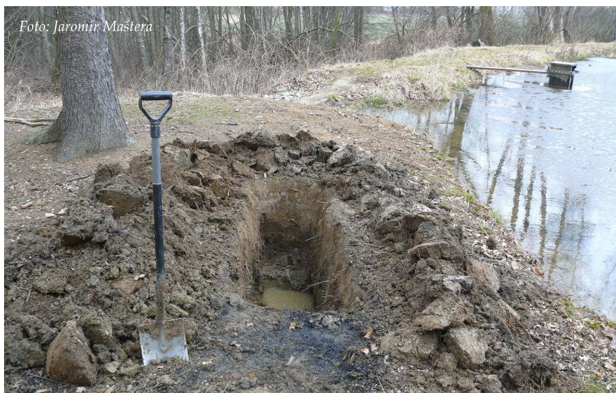
Obr. 31: Ruční oprava jednoho z průsaků rybníka Kulatina (březen 2019)
