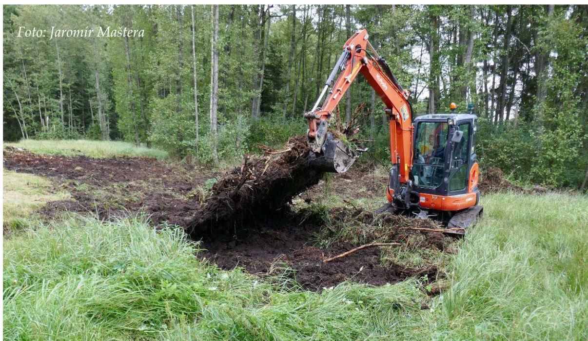
Obr. 63: Strhávání drnu a odstraňování smrkových pařezů z části rašeliniště (říjen 2019)
