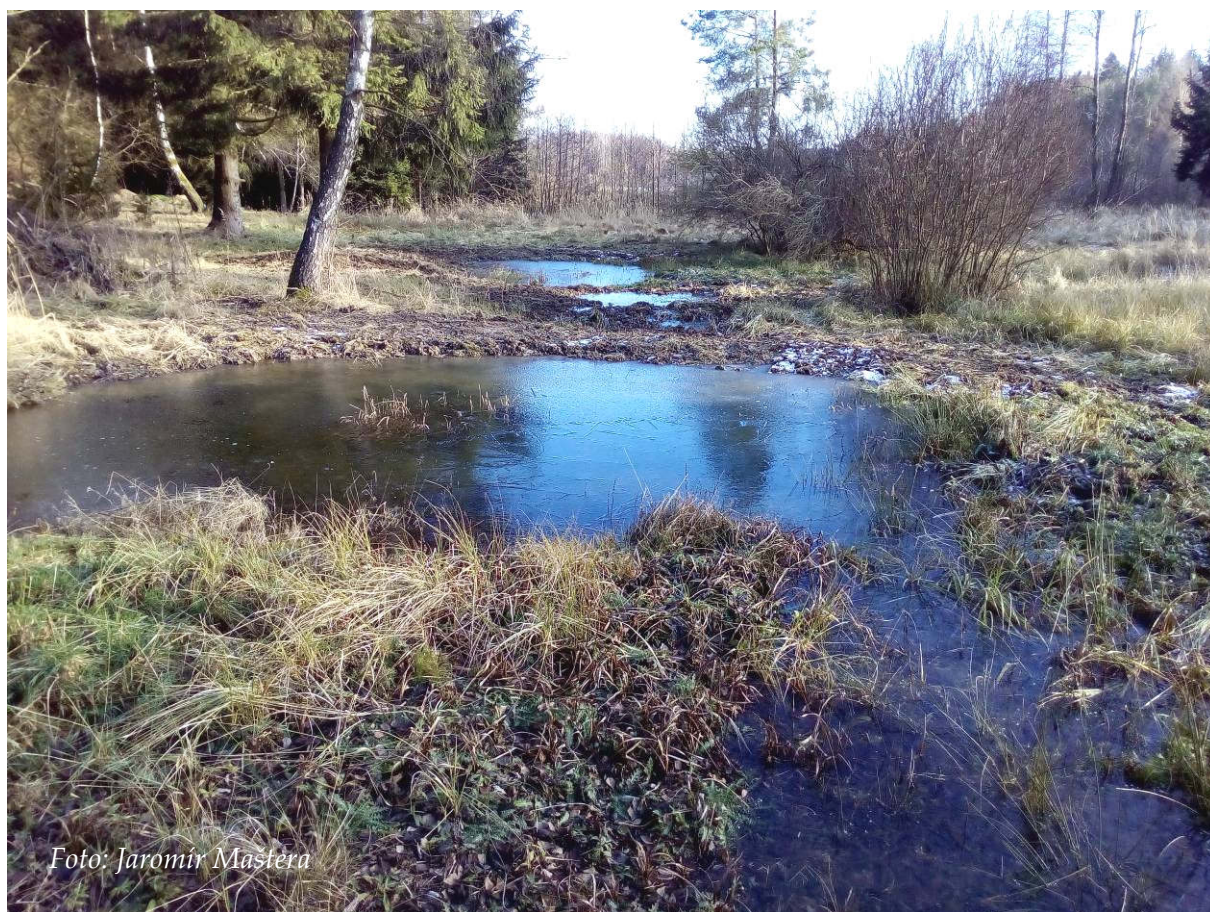
Obr. 82: Tůňe nad Rančářovským Okrouhlíkem po opravě průsaků (prosinec 2019)
