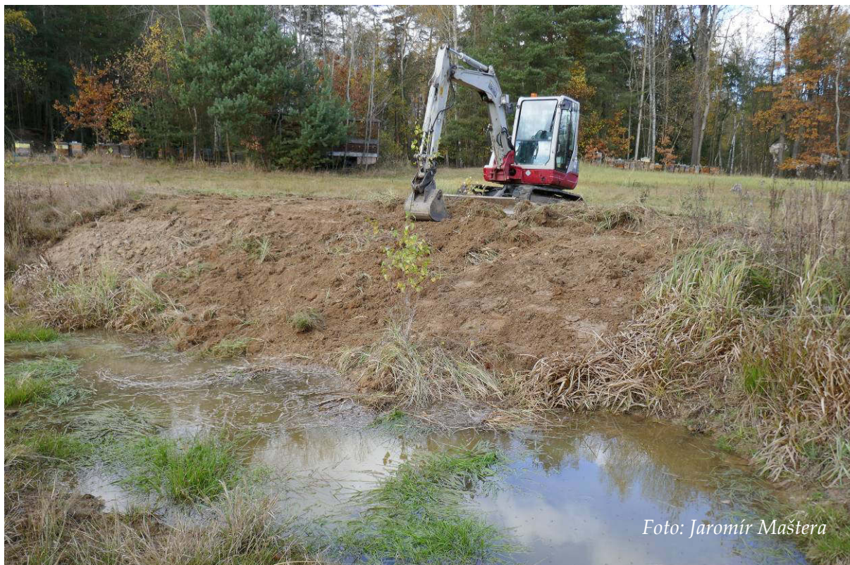
Obr. 37: Zpovolnění a snížení valu a oprava průsaků u velké tůně na Hulišťatech (listopad 2019)
