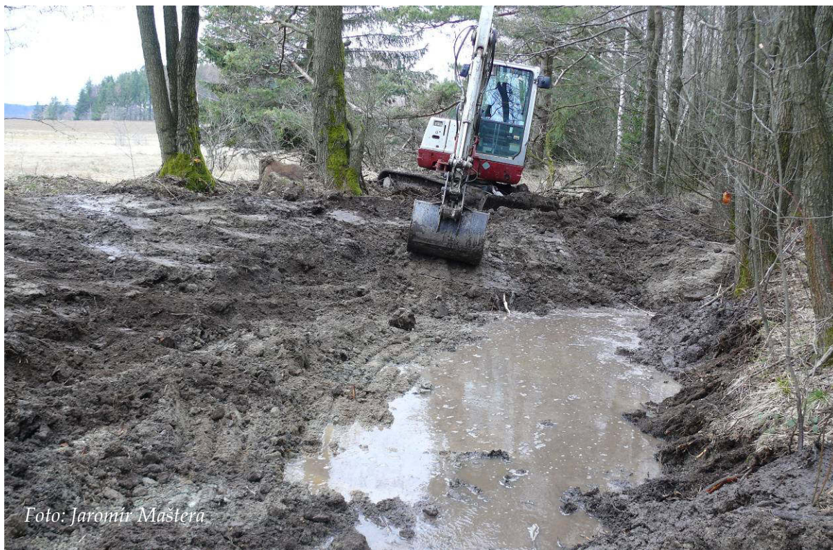
Obr. 64: Tvorba nové tůně rozšířením a přehrazením původního odvodňovacího příkopu (březen 2019)
