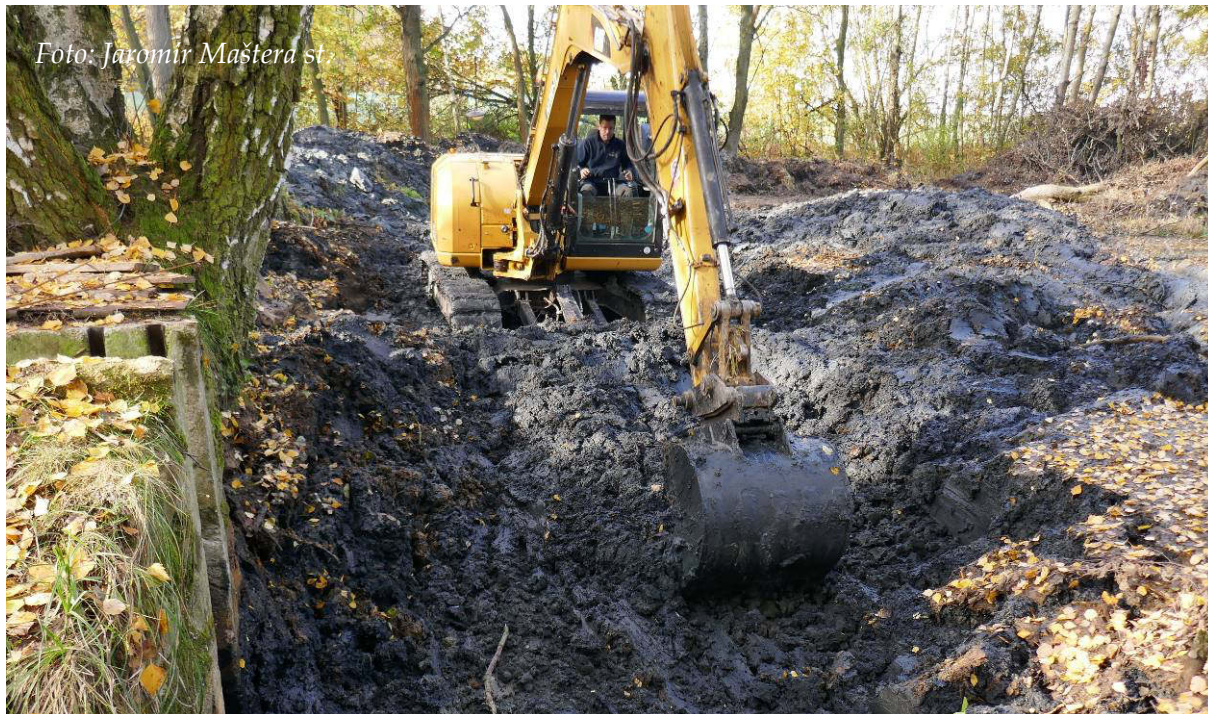
Obr. 68: Obnova vodní plochy a úprava hráze a břehů rybníčka Bednárník (říjen 2019)
