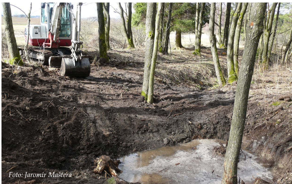
Obr. 65: Jedna z širokých zemních přehrážek v původním odvodňovacím příkopu (březen 2019)
