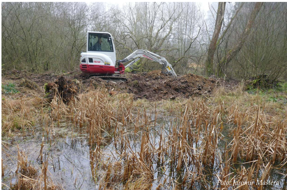
Obr. 27: Oprava průsaků jedné z tůní nad Rančířovským Okrouhlíkem (listopad 2019)
