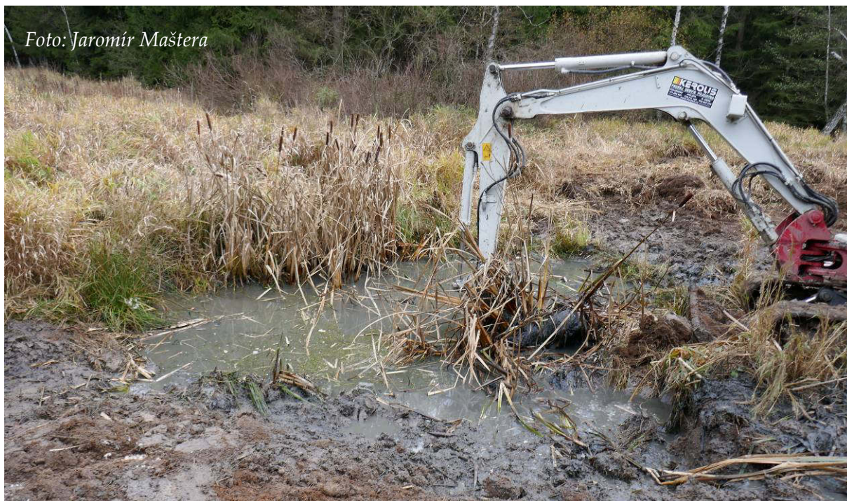
Obr. 69: Obnova jedné z tůní na podporu střevle potoční v lokalitě Staviště (listopad 2019)
