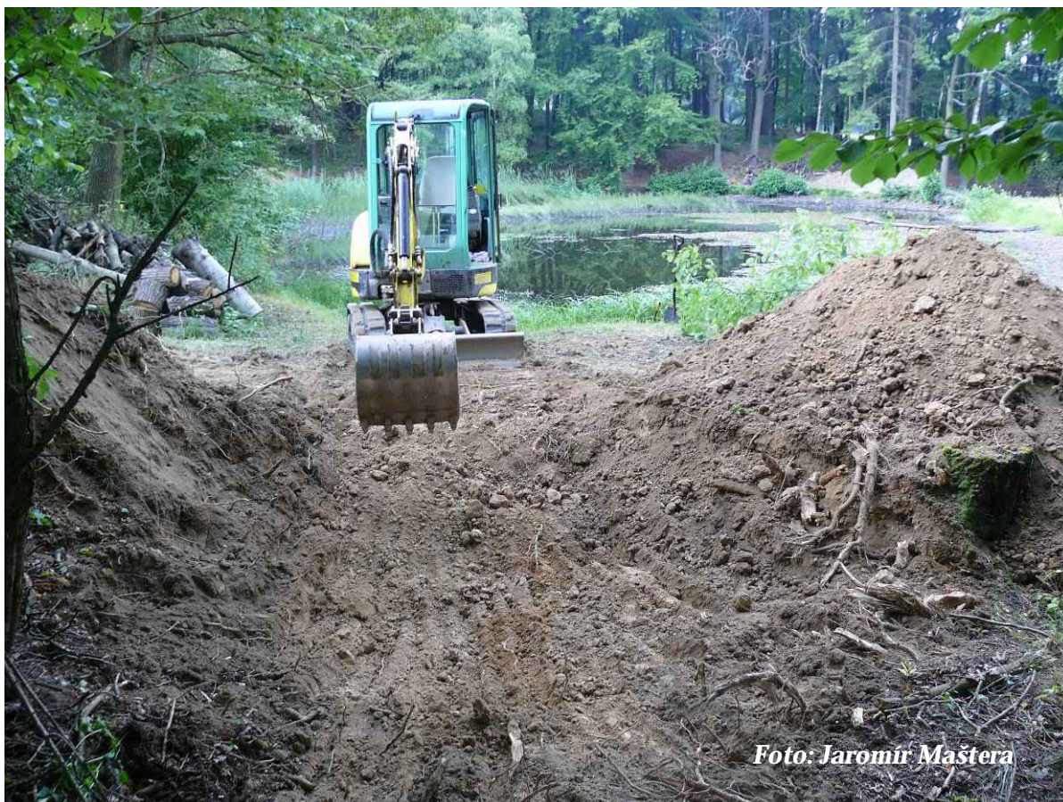
Foto 4: Vyhloubená jáma pro zimoviště (srpen 2013)
