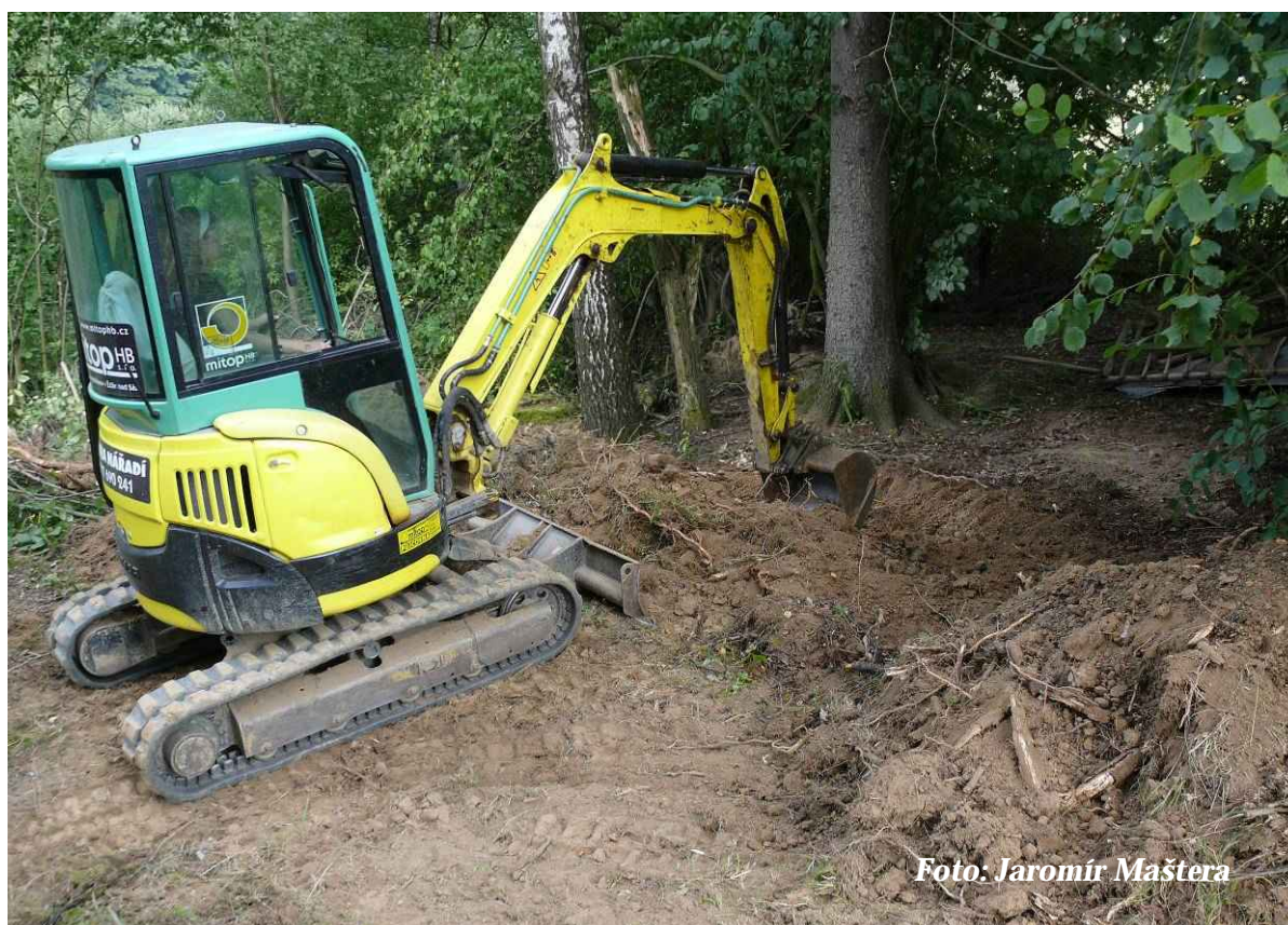
Foto 2: Začátek hloubení jámy – základu zimoviště (srpen 2013)
