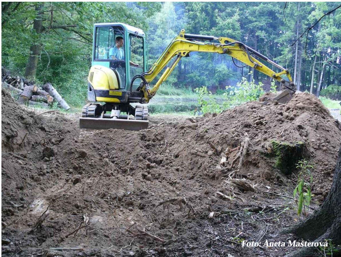
Foto 3: Hloubení jámy pro zimoviště minibagrem (srpen 2013)
