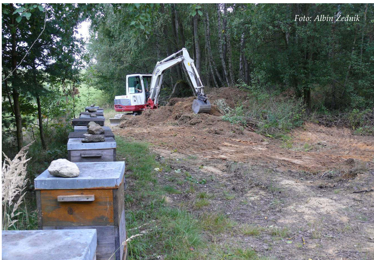
Foto 8: Strojní stržení drnu v části pískovny Hulišťata (září 2017)
