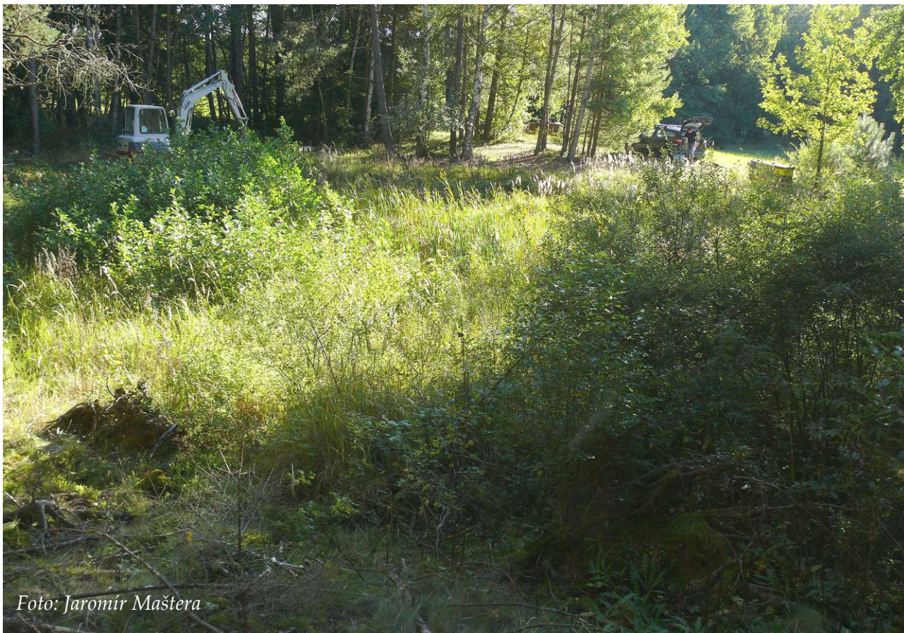
Foto 15: Srovnání – pískovna před realizací opatření (září 2017)
