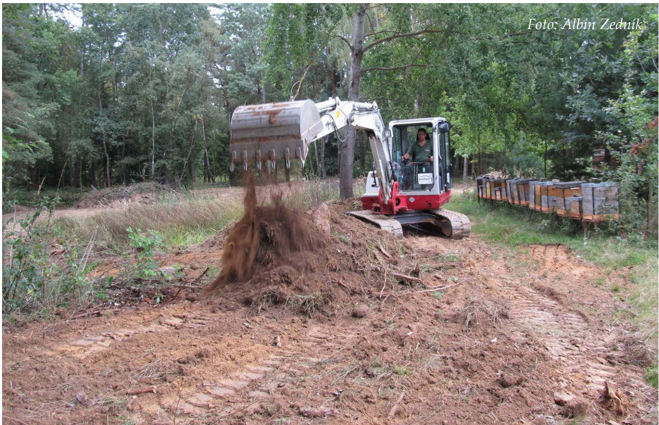
Foto 1: Strojní stržení drnu v části pískovny Hulišťata (září 2017)
