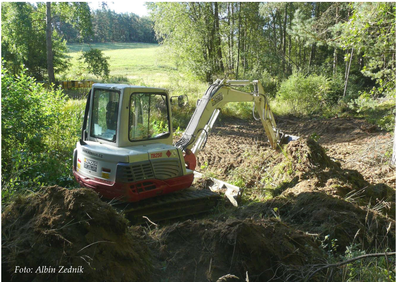
Foto 3: Strojní stržení drnu v části pískovny Hulišťata (září 2017)
