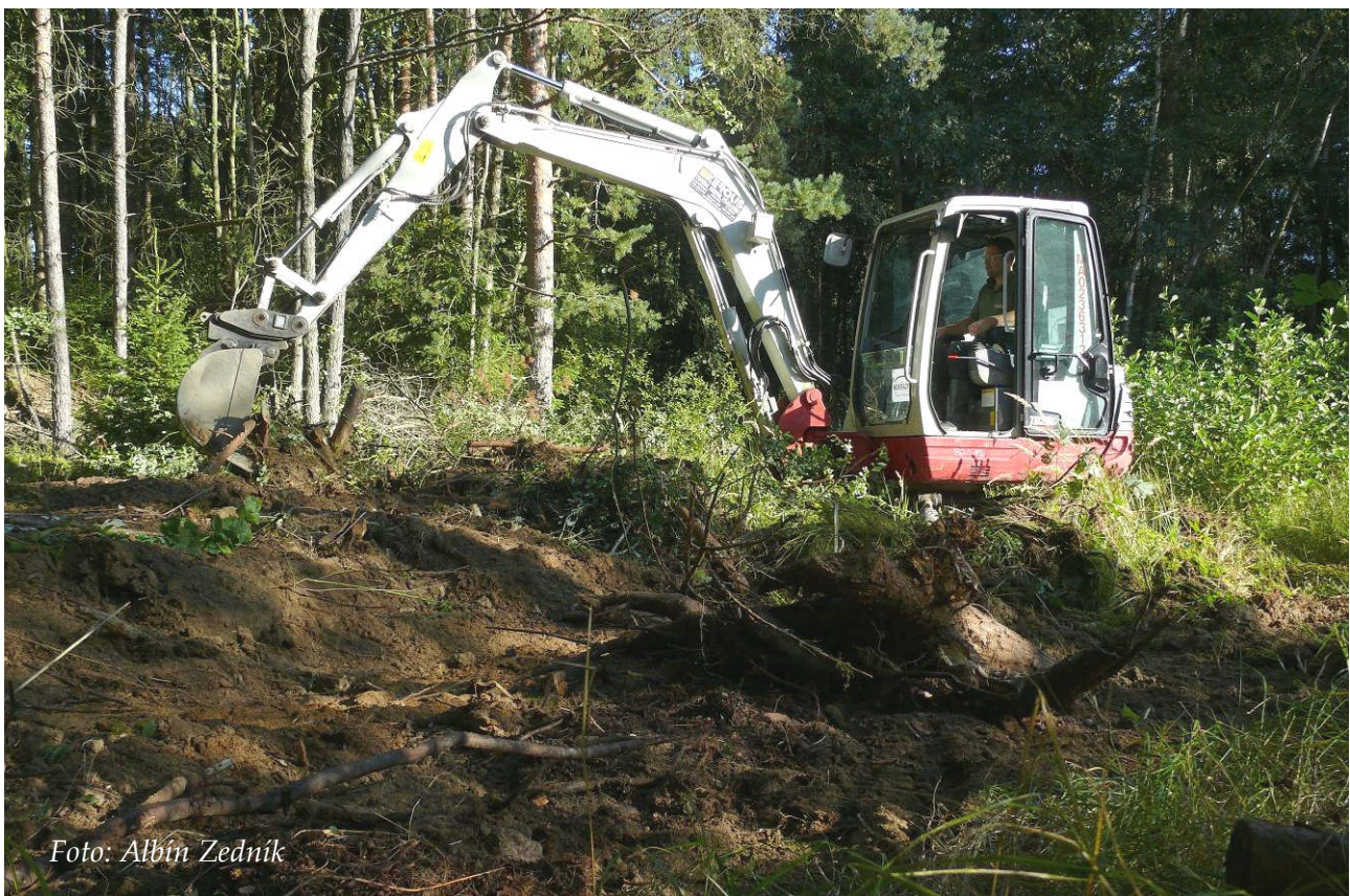
Foto 2: Strojní stržení drnu v části pískovny Hulišťata (září 2017)
