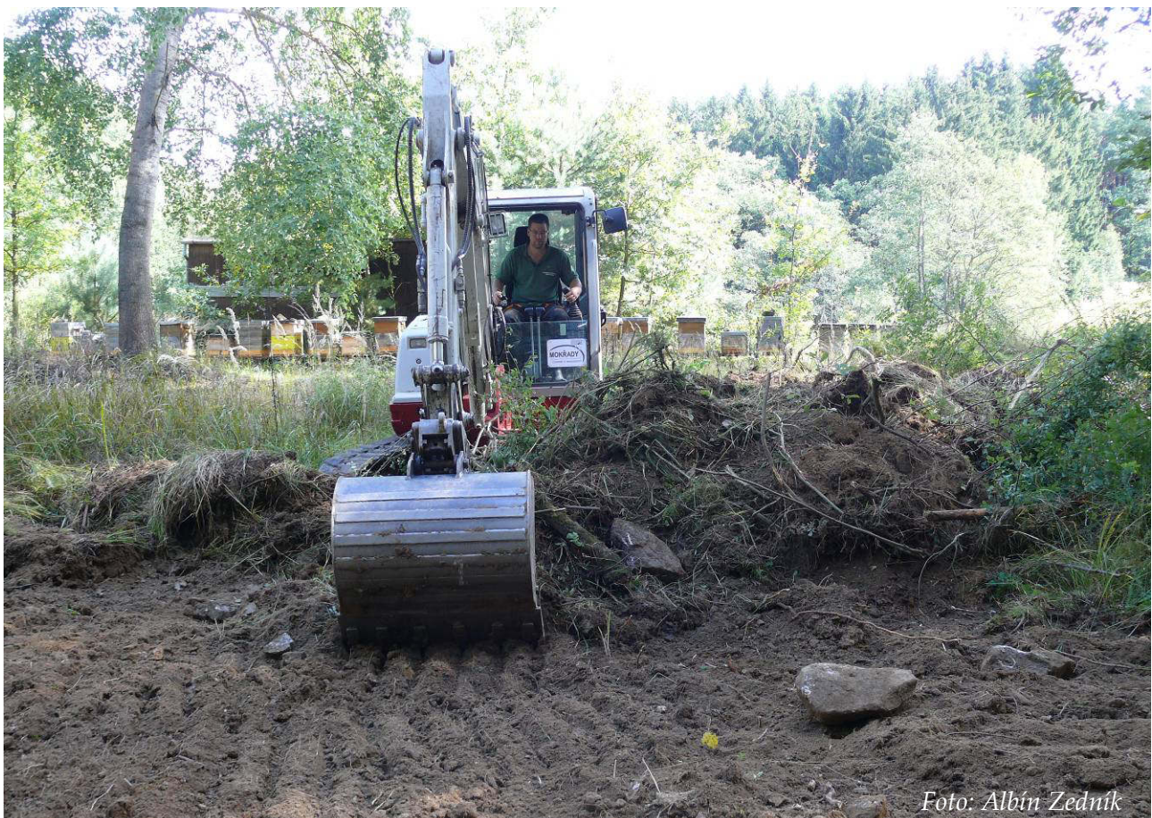
Foto 6: Strojní stržení drnu v části pískovny Hulišťata (září 2017)
