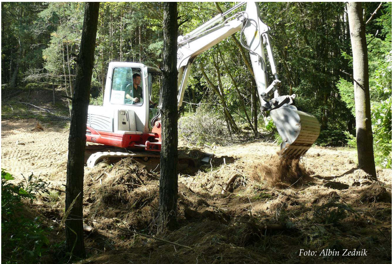
Foto 5: Ukládání stržené hmoty (drny + zemina) na degradovaný okraj pískovny (září 2017)
