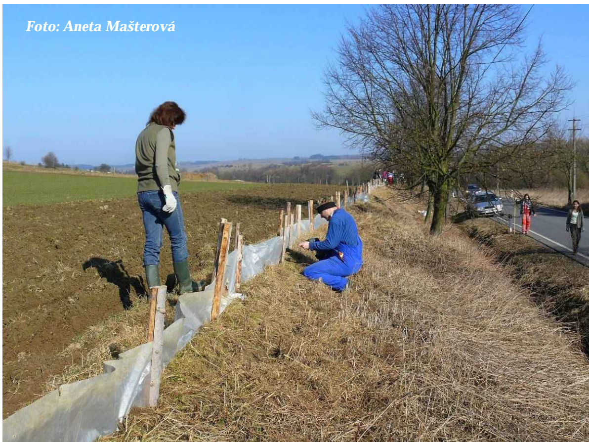
Foto 8: Finální fáze stavby zábran - sešroubování (březen 2012)
