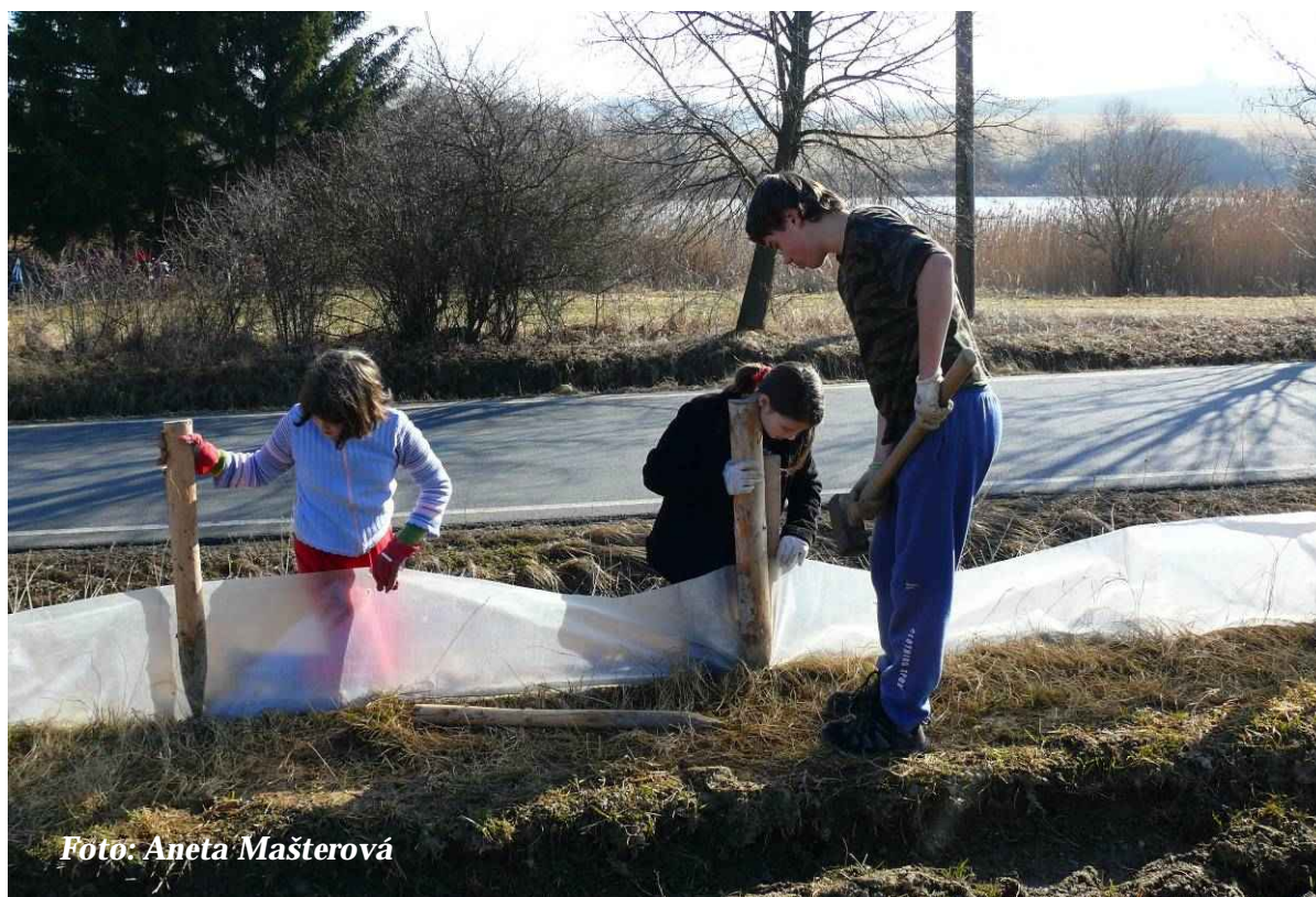
Foto 1: Ukotvování fólie – kompletování zábran (březen 2012)
