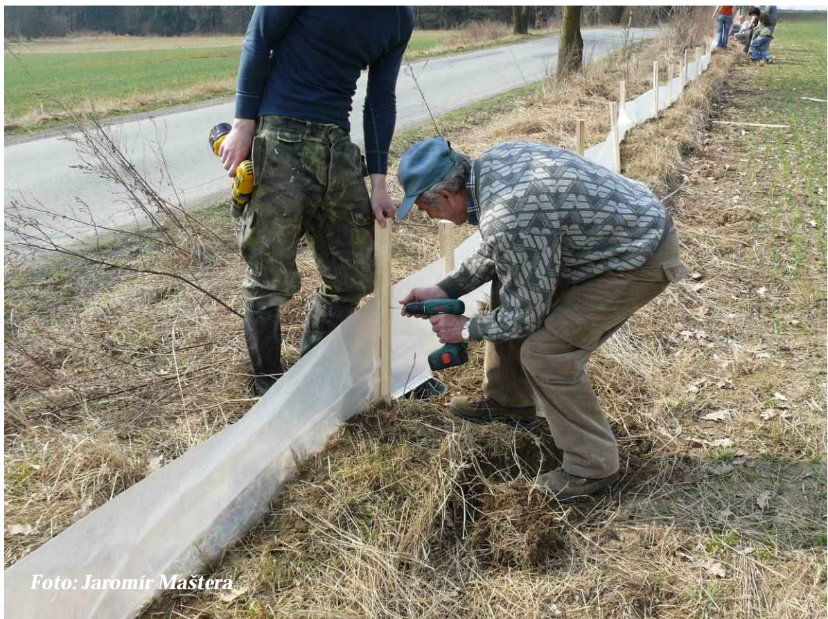
Foto 12: Kompletace zábran sešroubováním (březen 2012)
