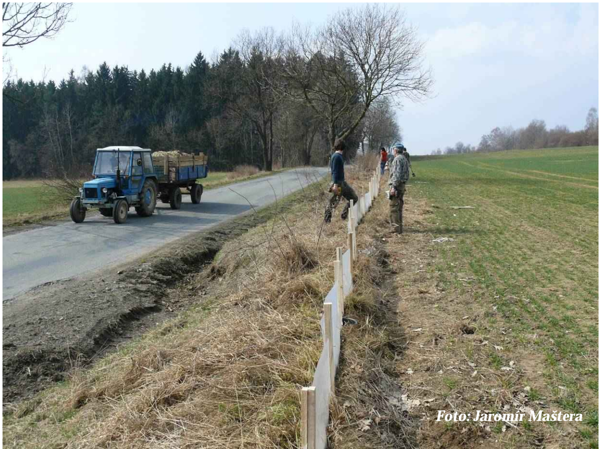
Foto 9: Pohled na hotovou část zábran (březen 2012)
