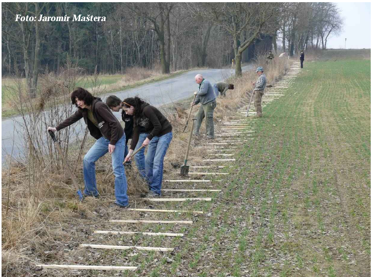
Foto 4: Vytváření drážky na folii v trase zábran (březen 2012)
