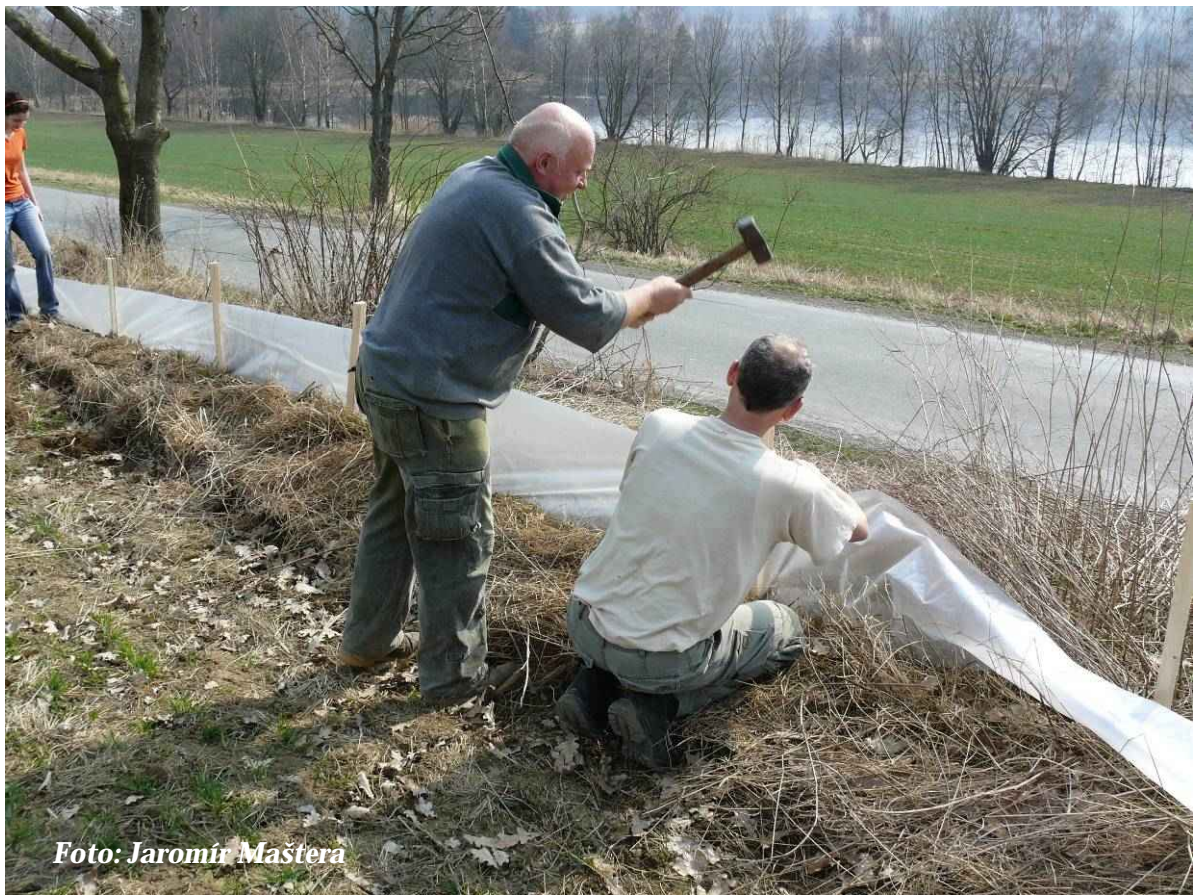
Foto 11: Ukotvování fólie, v pozadí rybník Sviták (březen 2012)
