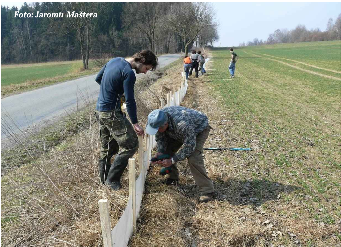
Foto 8: Finální fáze stavby zábran - sešroubování (březen 2012)
