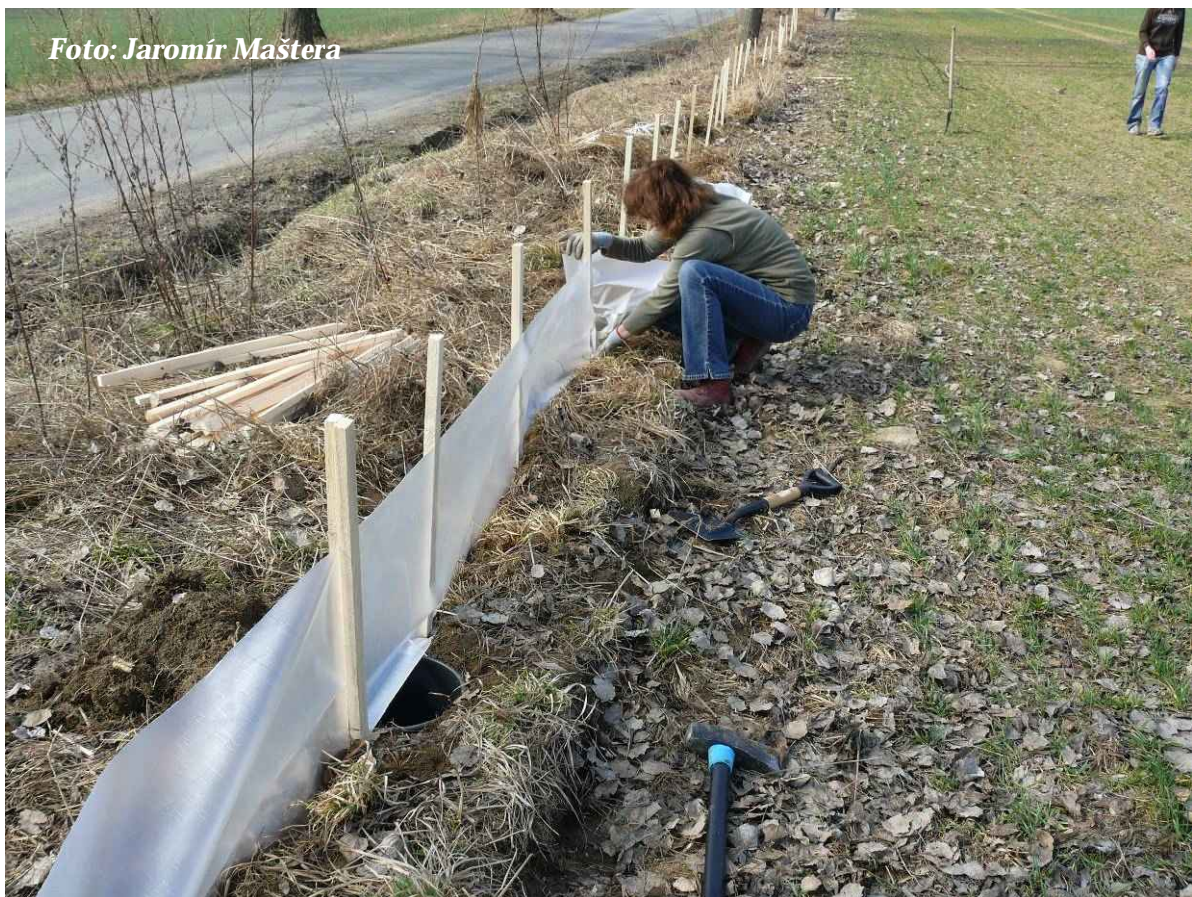
Foto 6: Natahování a upevňování fólie (březen 2012)
