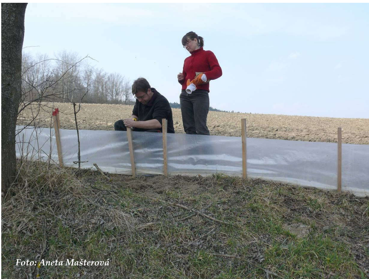
Foto 4: Finální upevnění zábran – šroubování folie ke kolíkům (březen 2015)
