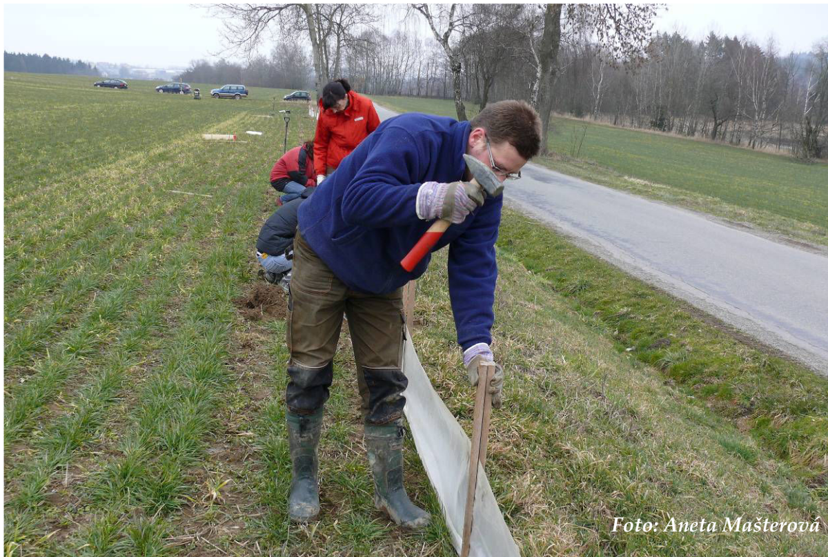
Foto 1: Budování zábran u Svitáku – zatlukání kůlů a upevňování folie (březen 2016)
