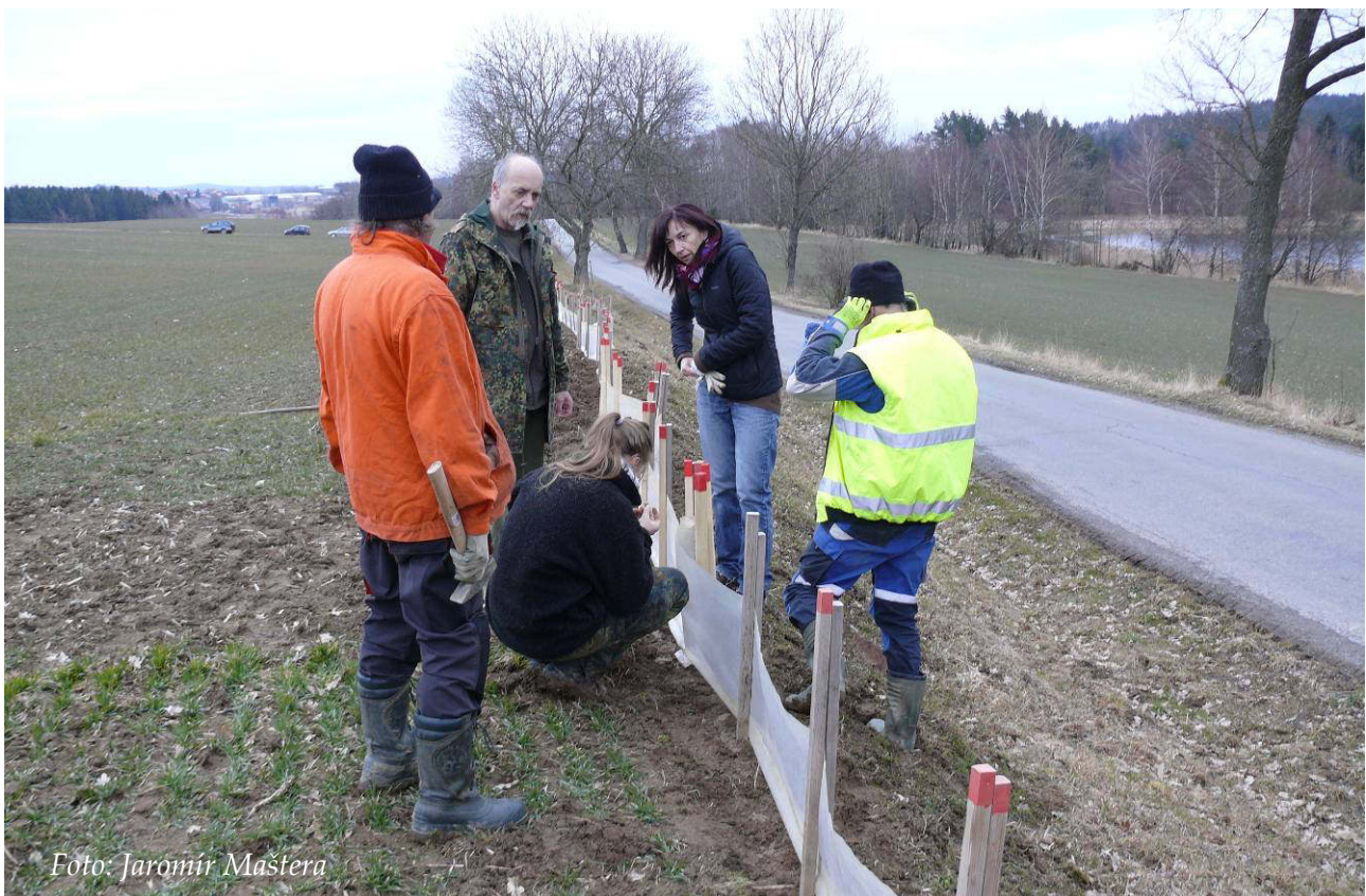
Foto 4: Finalizace a kontrola dočasných zábran (březen 2018)
