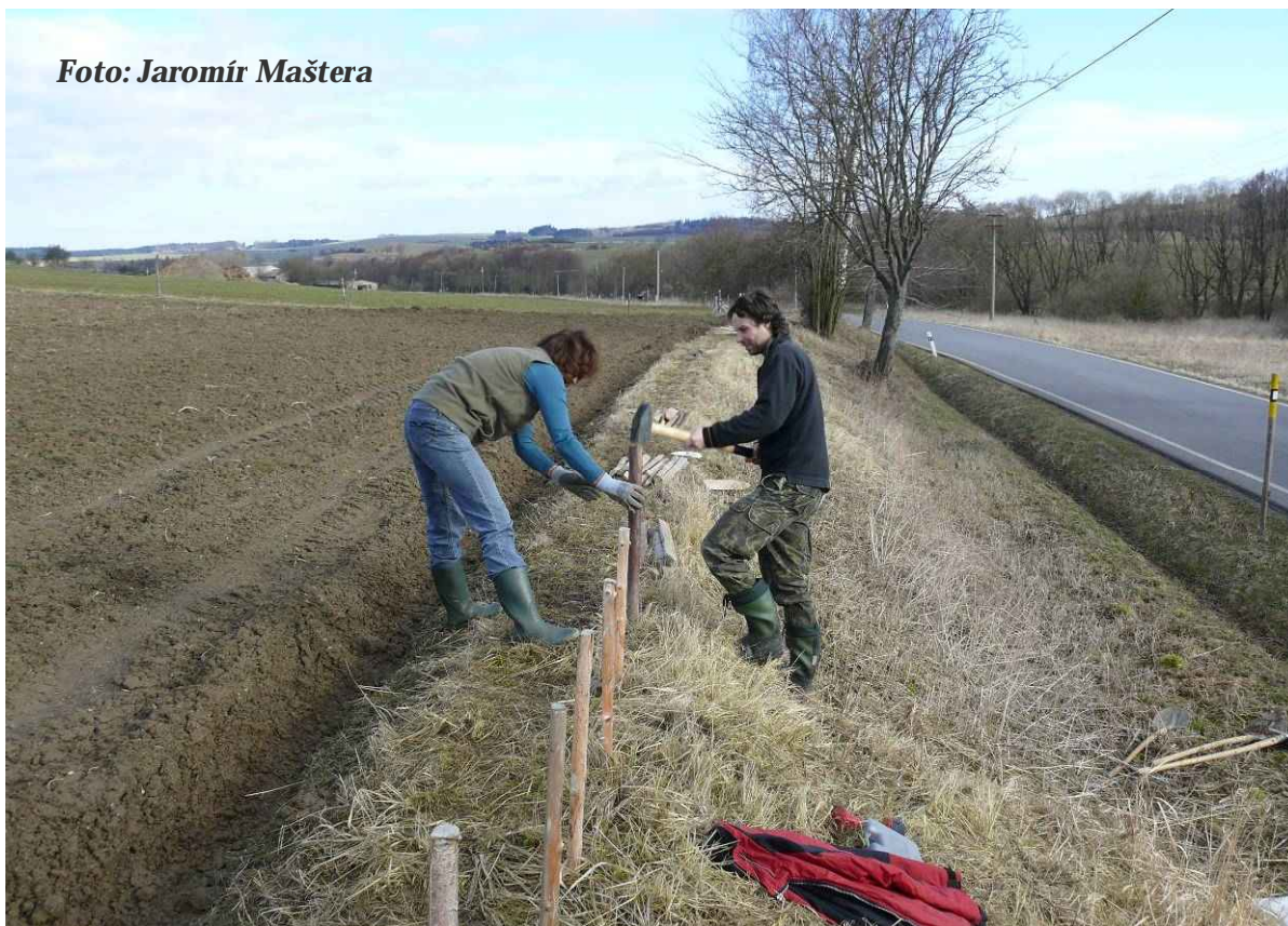
Foto 1: Začátek stavby zábran u Kamenice – zatlukání jedné řady kolíků (duben 2013)
