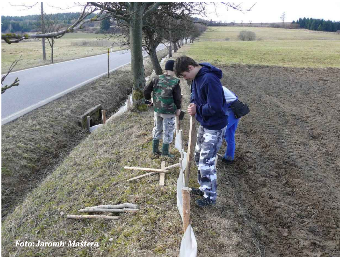
Foto 3: Ukotvování folie pomocí druhé řady kolíků (duben 2013)
