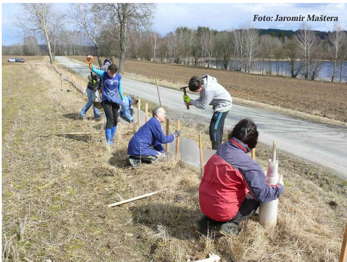
Foto 24: Budování zábran u Svitáku (duben 2013)
