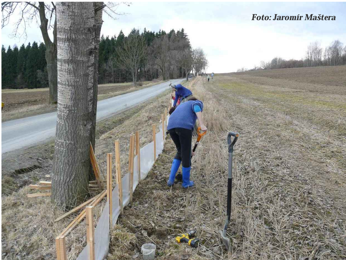
Foto 19: Zatloukání kolíků a natahování folie (duben 2013)
