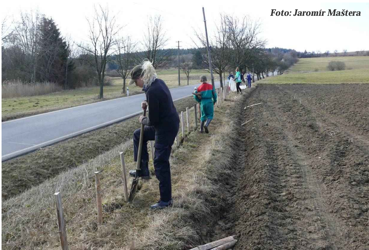
Foto 2: Rozevírání zemní drážky rýčem (duben 2013)
