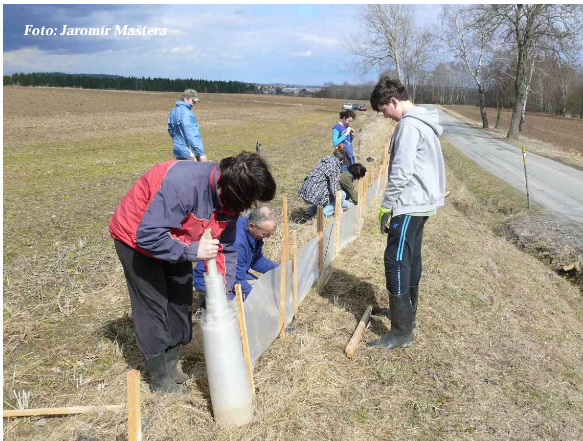
Foto 23: Natahování a ukotvování folie u Svitáku (duben 2013)
