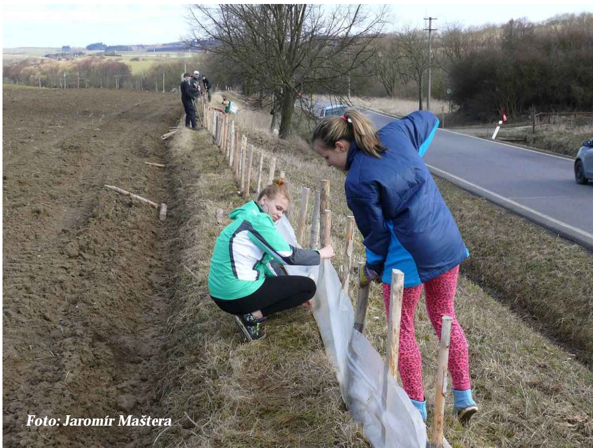
Foto 4: Natahování folie a zasouvání do drážky (duben 2013)
