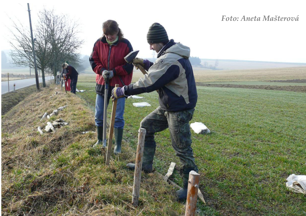
Foto 1: Začátek stavby zábrán u Kamenice – zatloukání jedné řady kolíků (březen 2014)
