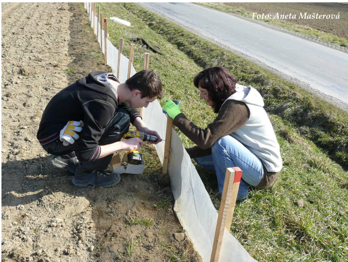
Foto 12: Spojování kolíků a folie vruty (březen 2014)
