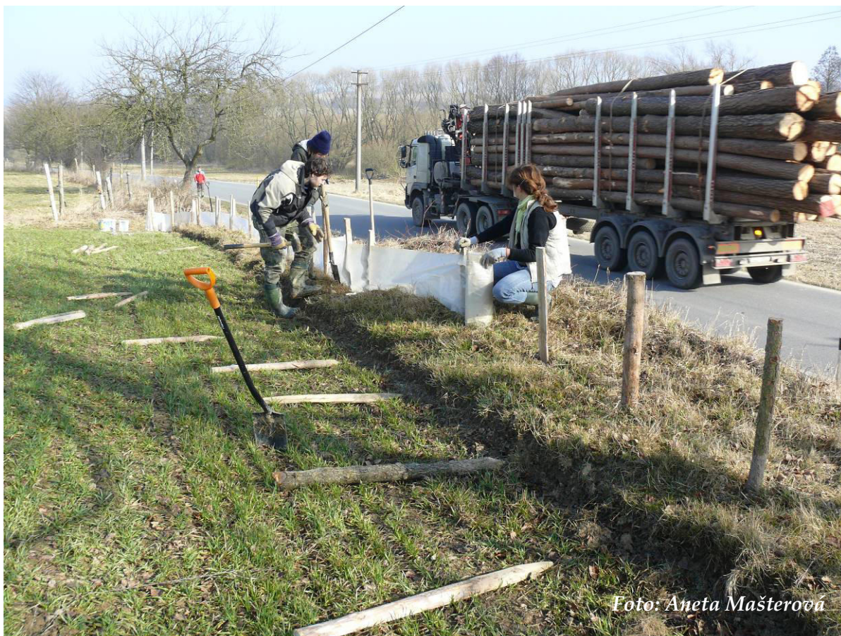
Foto 3: Instalace zábran ve spodní části (březen 2014)
