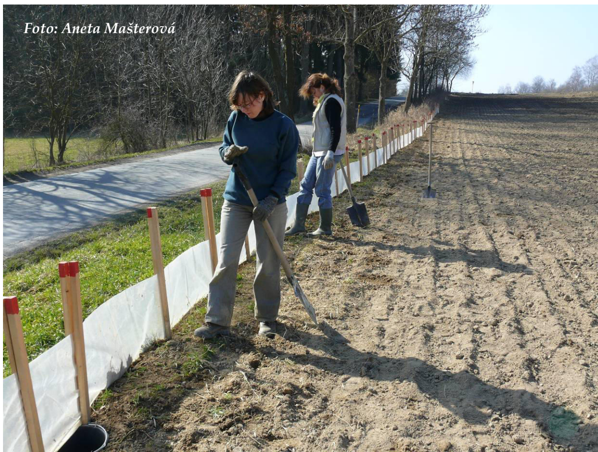
Foto 14: Zhutňování a doplňování zeminy u zábran (březen 2014)
