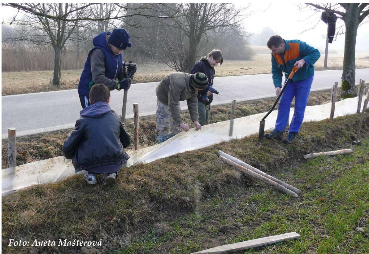
Foto 2: Natahování folie vkládání do zemní drážky (březen 2014)
