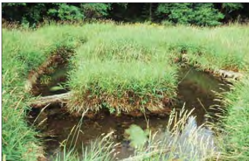
U nově budovaných nádrží je někdy vhodné zabránit sesuvu stěn obložením dřevěnou kulatinou (foto: Karel Rozínek)
