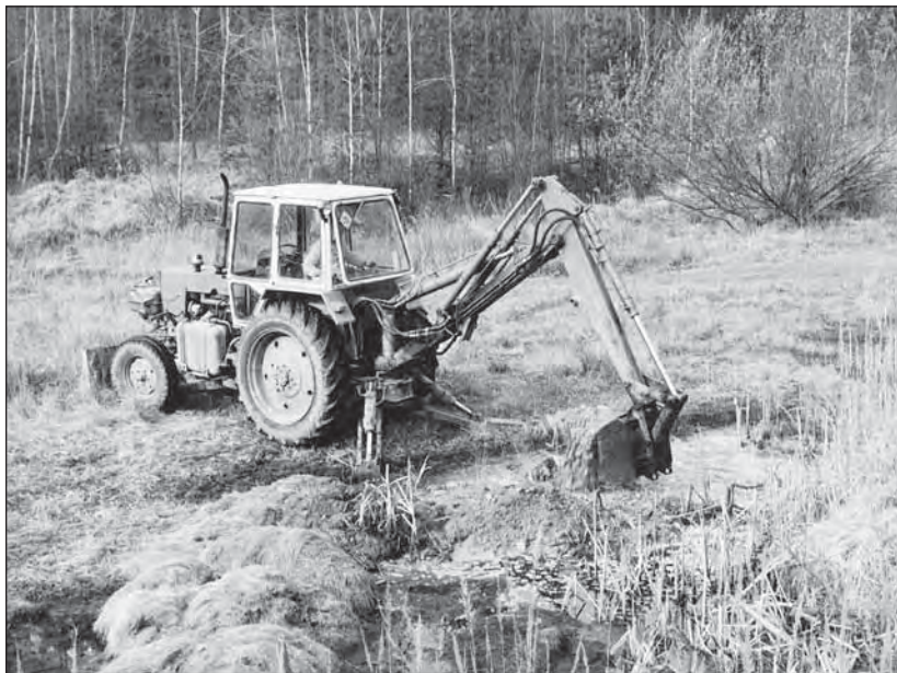
Obnova zavezené tůňky - situace na lokalitě těsně po započetí asanačních prací (foto: M. Mikát)
