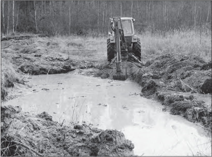
S pomocí techniky byla nádrž vyčištěna a rozšířena (foto: M. Mikát)
