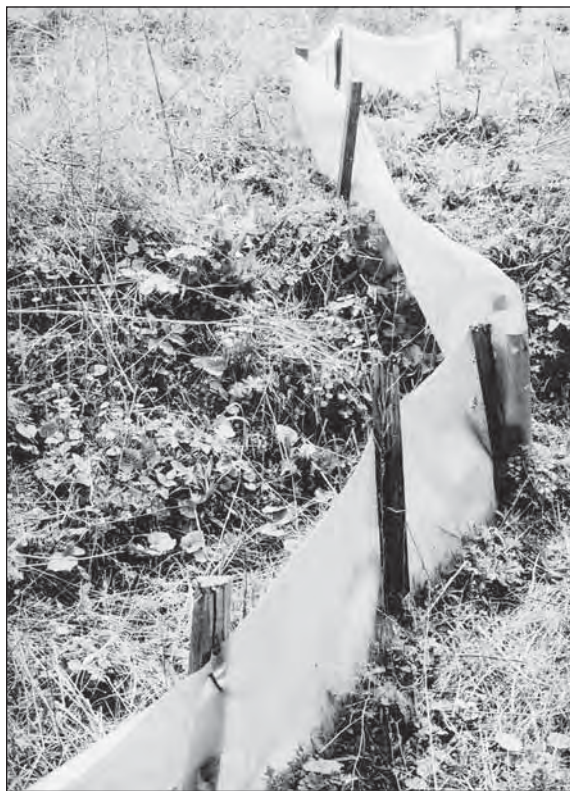
Zábrana musí být u země zahrnuta, aby ji obojživelníci nemohli podlézt (foto: M. Mikát)
