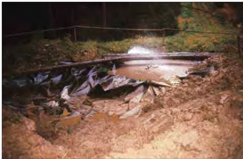
U nádrží budovaných na propustném podloží je vodu nutno zadržovat nepropustnou fólií (foto: R. Rozínek)
