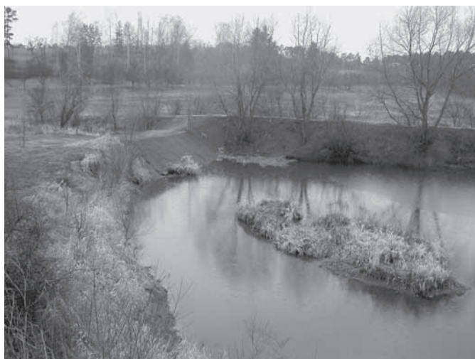
Obr. 3 a 4: Příklad opravdu „citlivého“ přístupu při úpravě vodní plochy. Původní mělká laguna (nahore) byla od rozlehlejší, avšak nezarybněné vodní plochy (dole) nesmyslně oddělena strmou hrází, přičemž její nejcennější partie byly z části zasypány. Větší vodní plocha přitom vznikla scelením několika menších! Vše v údolní nivě kdesi ve středních Čechách (foto Jiří Vojar).
