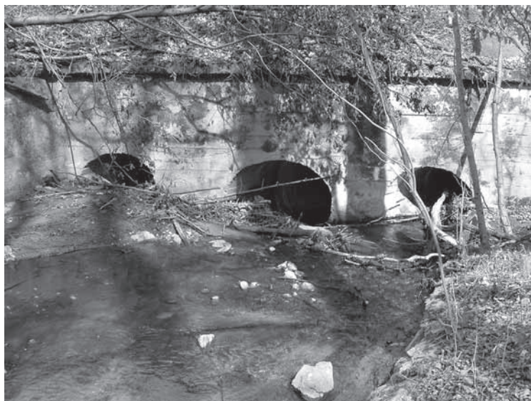
Obr. 13: Příklad kompromisního řešení trubního propustku, který zvládá současné převádění trvalých průtoků středním profilem i případnou migraci menších obratlovců menšími a výše položenými profily na okrajích. Tento propustek slouží jako migrační objekt zejména pro skokany hnědé, reprodukcí nádrž je umístěna cca 200 m po proudu vodoteče. Funkčnost objektu by podpořilo částečné odstranění naplavených sedimentů. Karlovarská silnice v blízkosti Lubence (foto Jiří Vojar).
