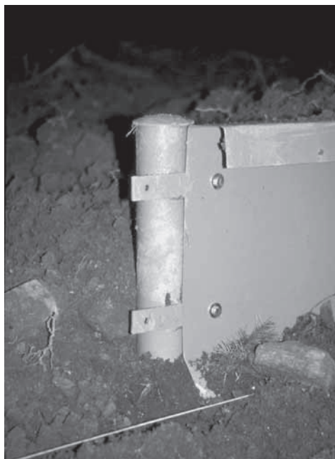
Obr 15: Detail trvalé naváděcí zábrany. Proti směru tahu je v horní části zábrany vytvořen lem bránící jejímu překonání, z druhé strany je bariéra přikrtnuta zeminou (foto Roman Rozínek).
