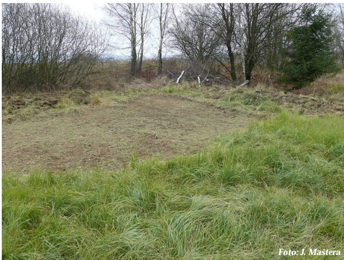
Foto 8: Louka po stržení drnu - dokončovací práce (listopad 2011)
