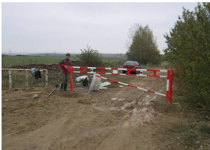
Foto 16: Instalace jedné ze závor v roce 2009. © V. Kodet
