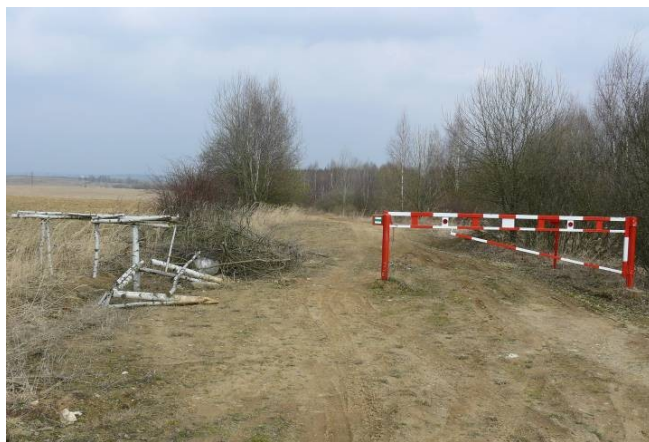
Foto 18: Zničené dřevěné oplocení u závory z roku 2009 (březen 2011). © A. Zedníková ▲
