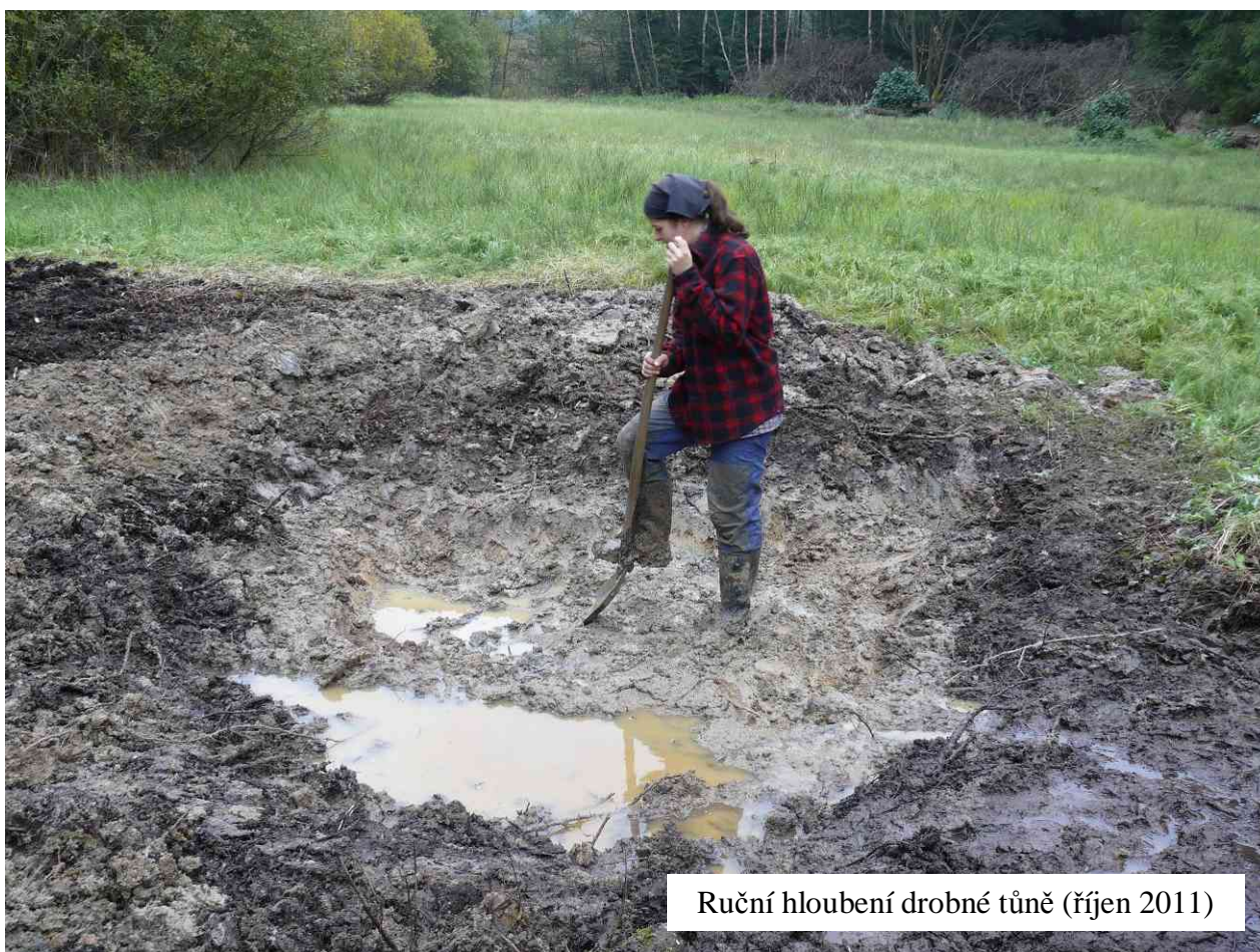
Ruční hloubení tůně 25 m 2 (říjen 2011)
