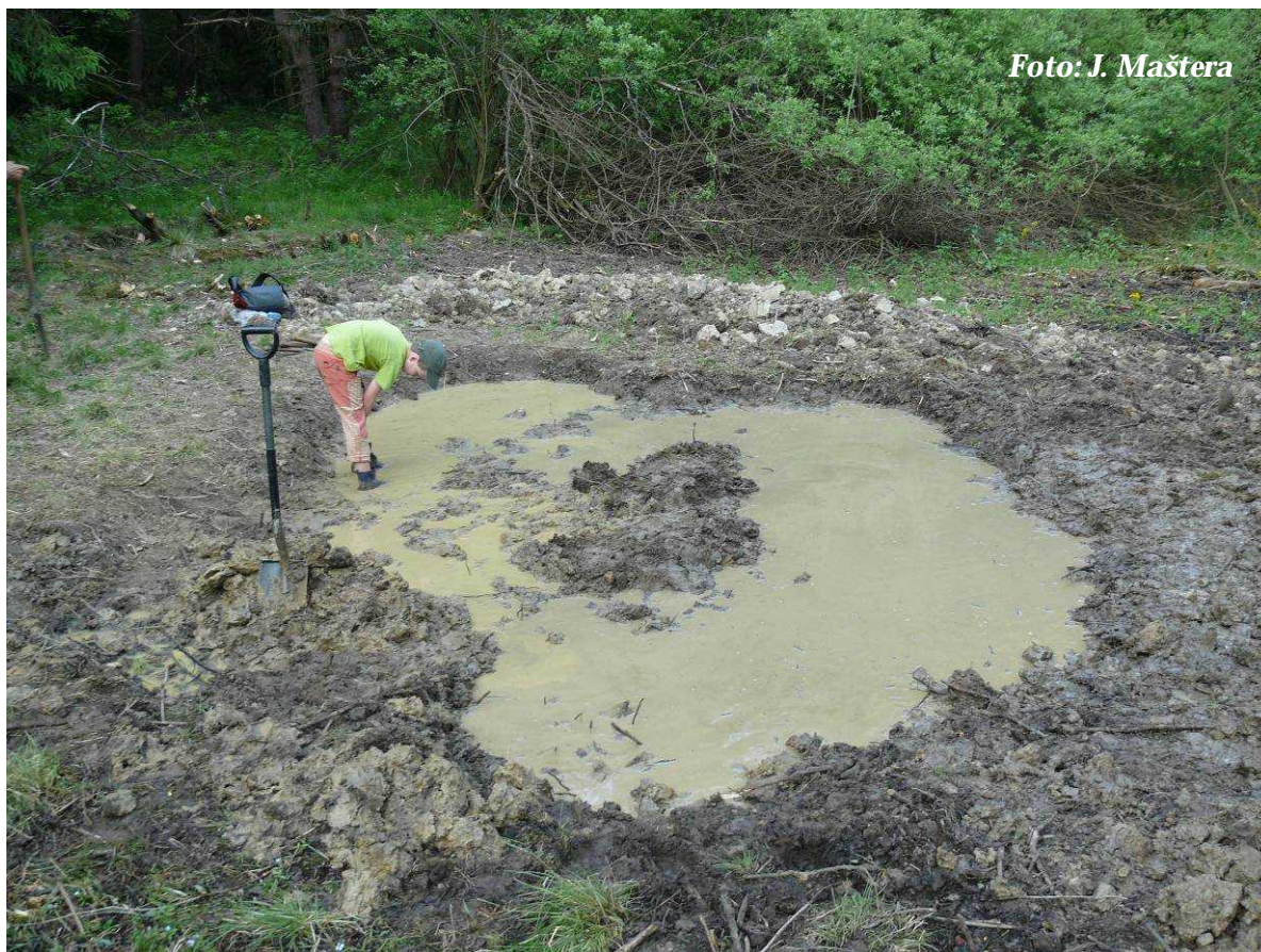
Foto 17: Téměř dokončené dílo... (květen 2012)
