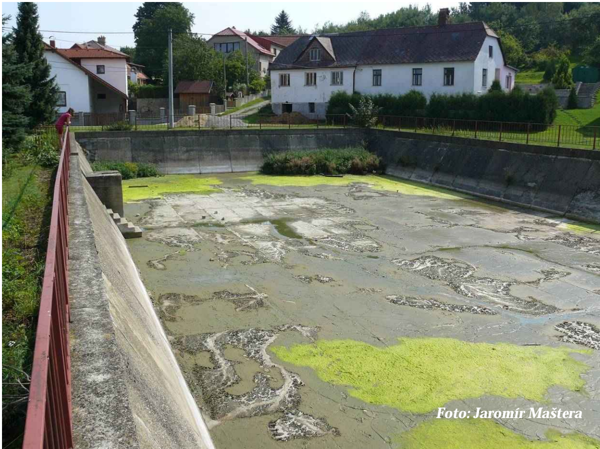
Foto 15: Řehořovská nádrž krátce po vypuštění (září 2012)
