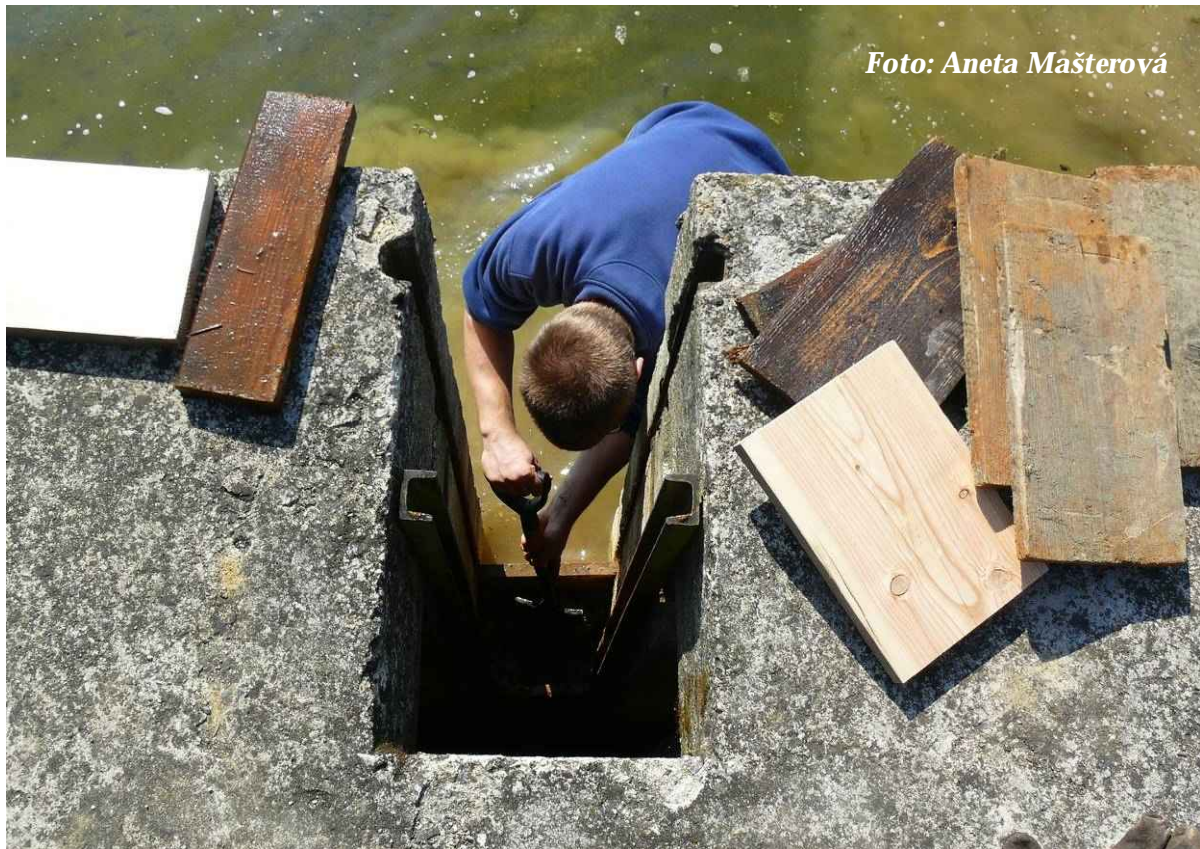
Foto 1: Osazování dluží do požeráku a zajílování (březen 2012)
