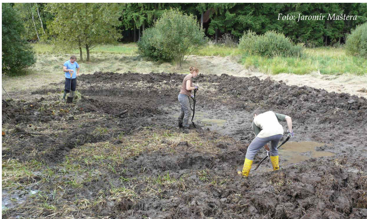
Obr. 27: Ruční hloubení velké a zároveň mělké tůně pro kuňku pod Ochozem (září 2012)
