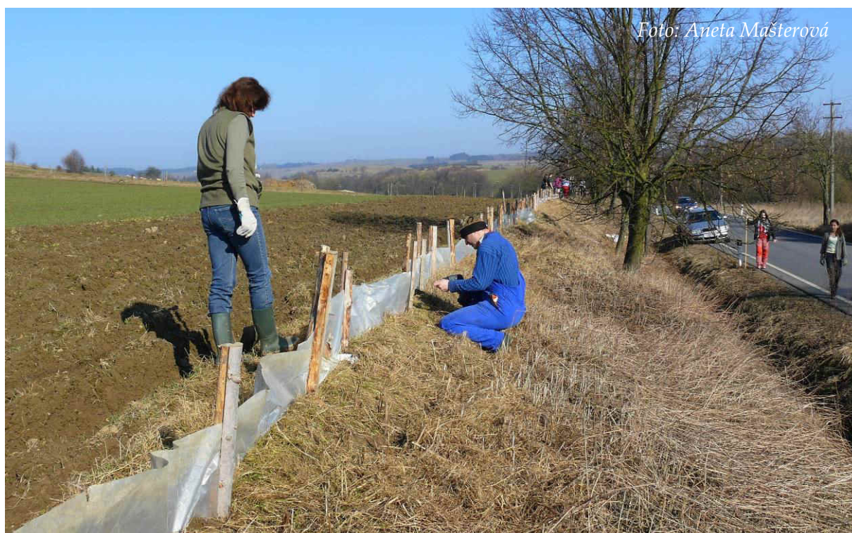
Obr. 1: Instalace zábran u Kamenice (březen 2012)
