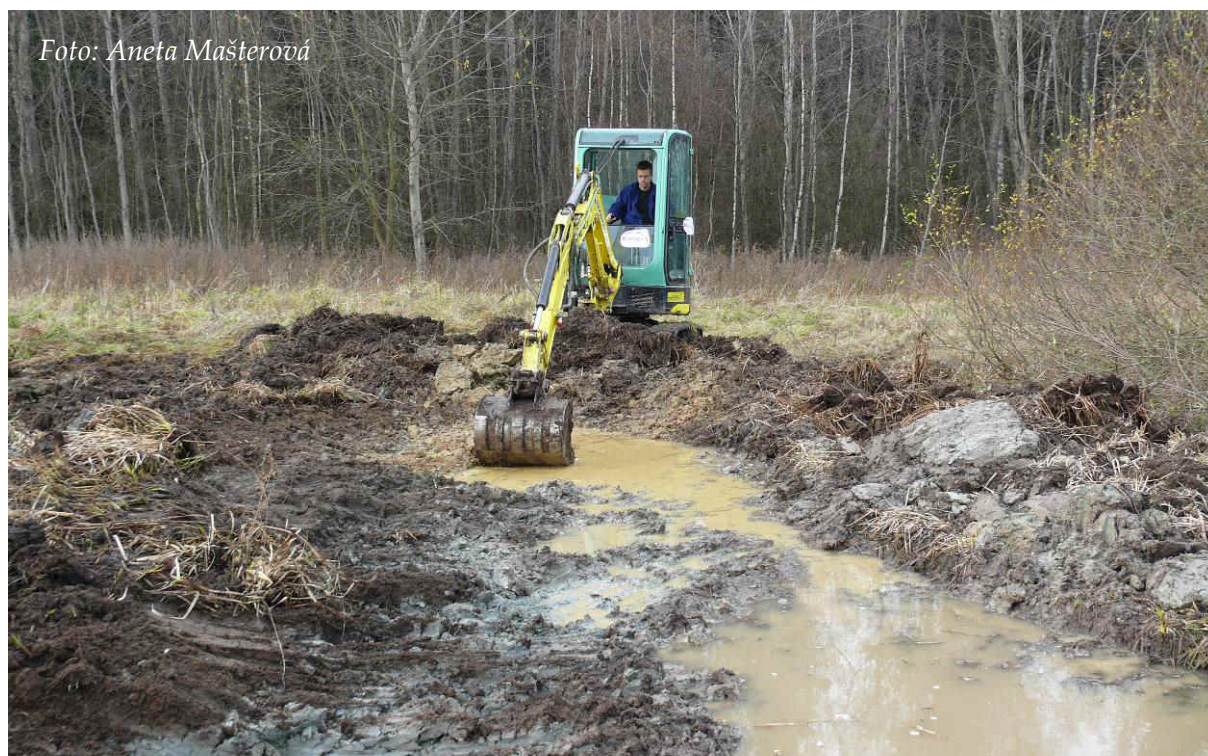
Obr. 24: Strojní hloubení mělké tůně pro kuňku na lokalitě Hulišťata (listopad 2012)
