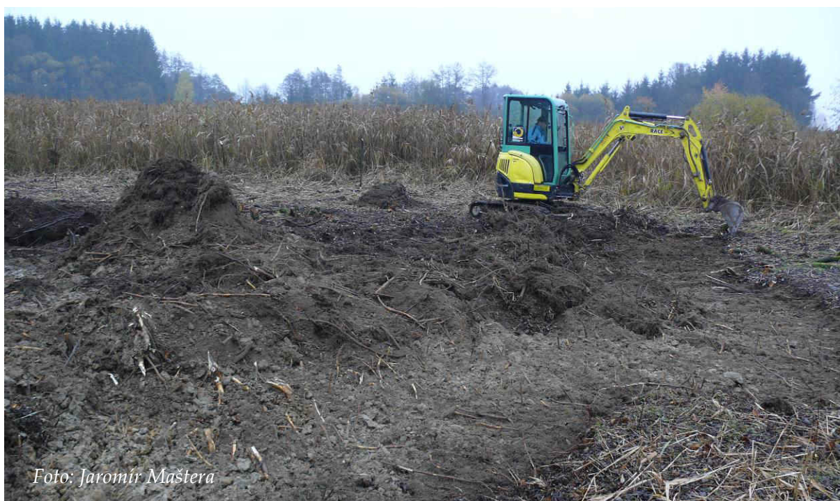
Obr. 30: Strojní hloubení mělké tůně o ploše 280 m 2 u Rychtářského rybníka (konec října 2012)
