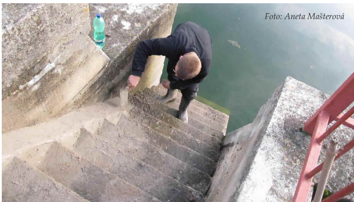
Obr. 26: Betonování nové migrační rampy při okraji schůdků (listopad 2012)
