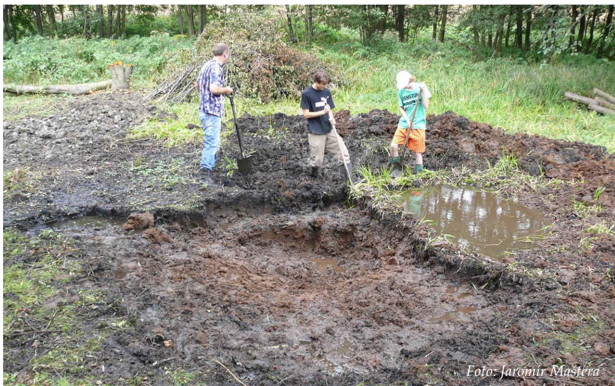
Obr. 20: Ruční hloubení tůň po částech systémem hrázkování (srpen 2012)
