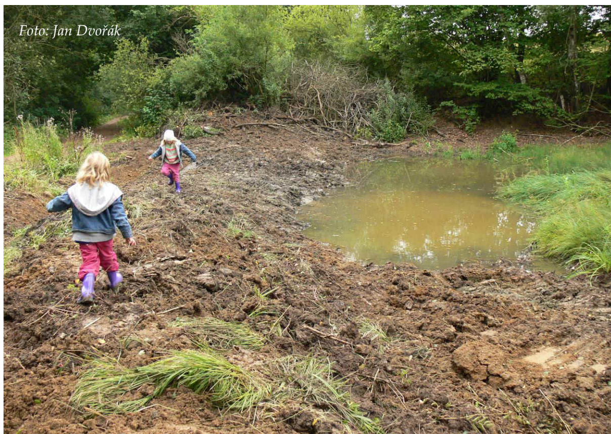
Obr. 38: Opravená a částečně odbahněná tůň pod Lyžařem (září 2013)
