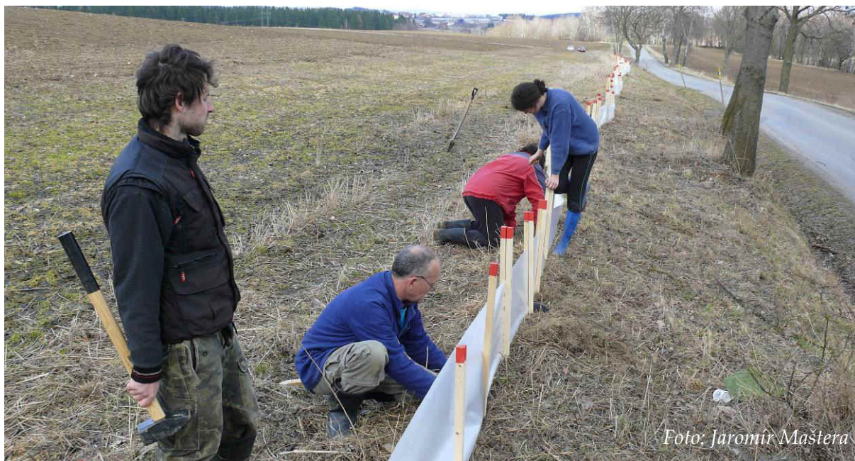
Obr. 4: Instalace zábran u Svitáku (duben 2013)
