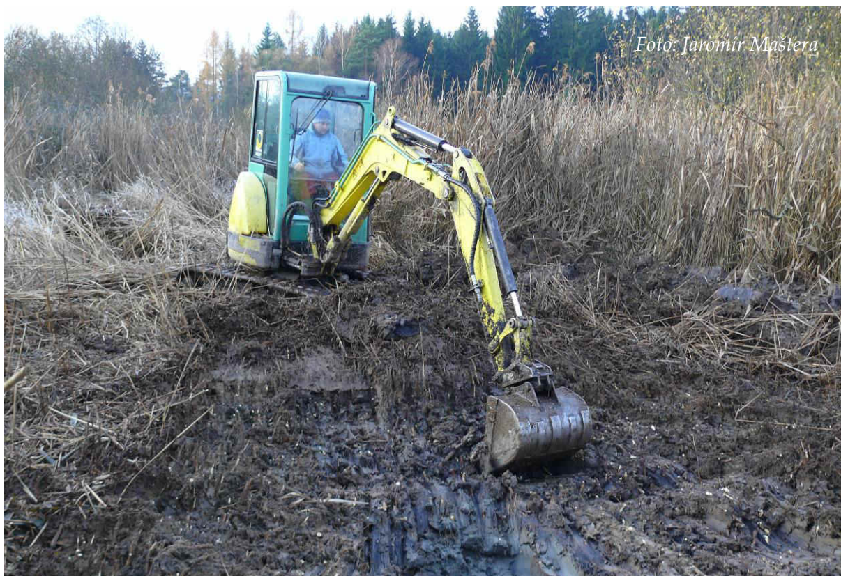
Obr. 27: Hloubení menší tůně pásovým minibagrem (listopad 2013)
