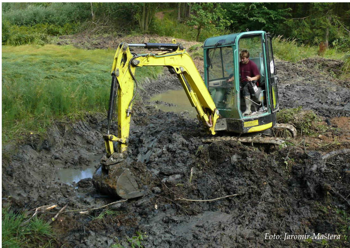
Obr. 20: Obnova nejvíce zazemněné části tůně byla provedena strojně (září 2013)
