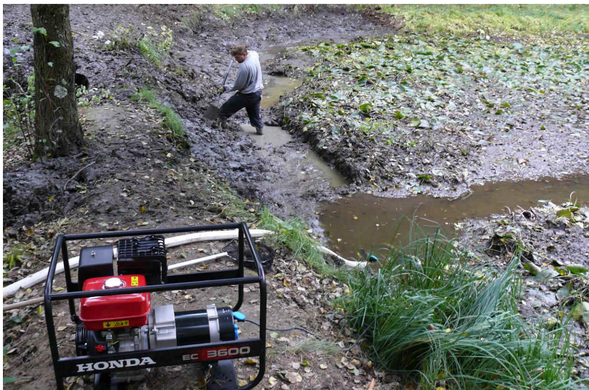
Obr. 31: Odčerpávání vody pomocí centrály a ruční pročištění dna jezírka (září 2013)
