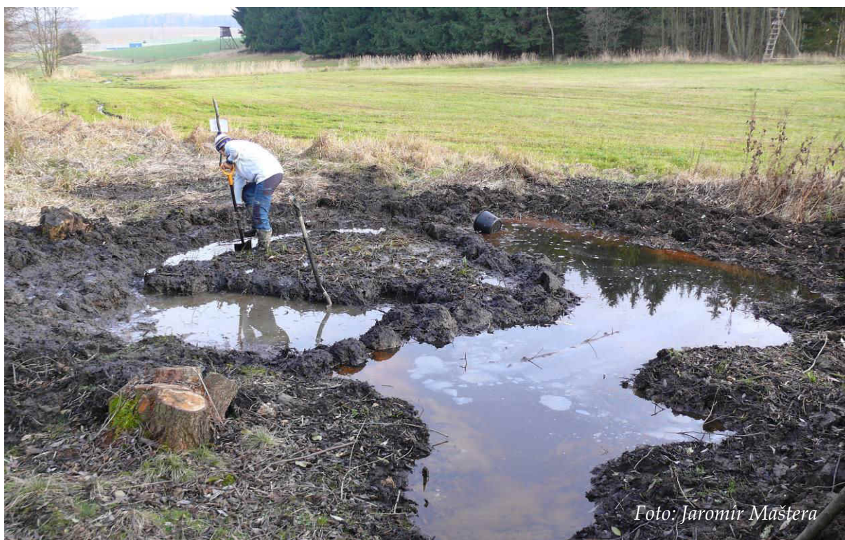
Obr. 34: Hloubení největší letošní tůně muselo být provedeno po částech - hrázkováním (listopad 2013)
