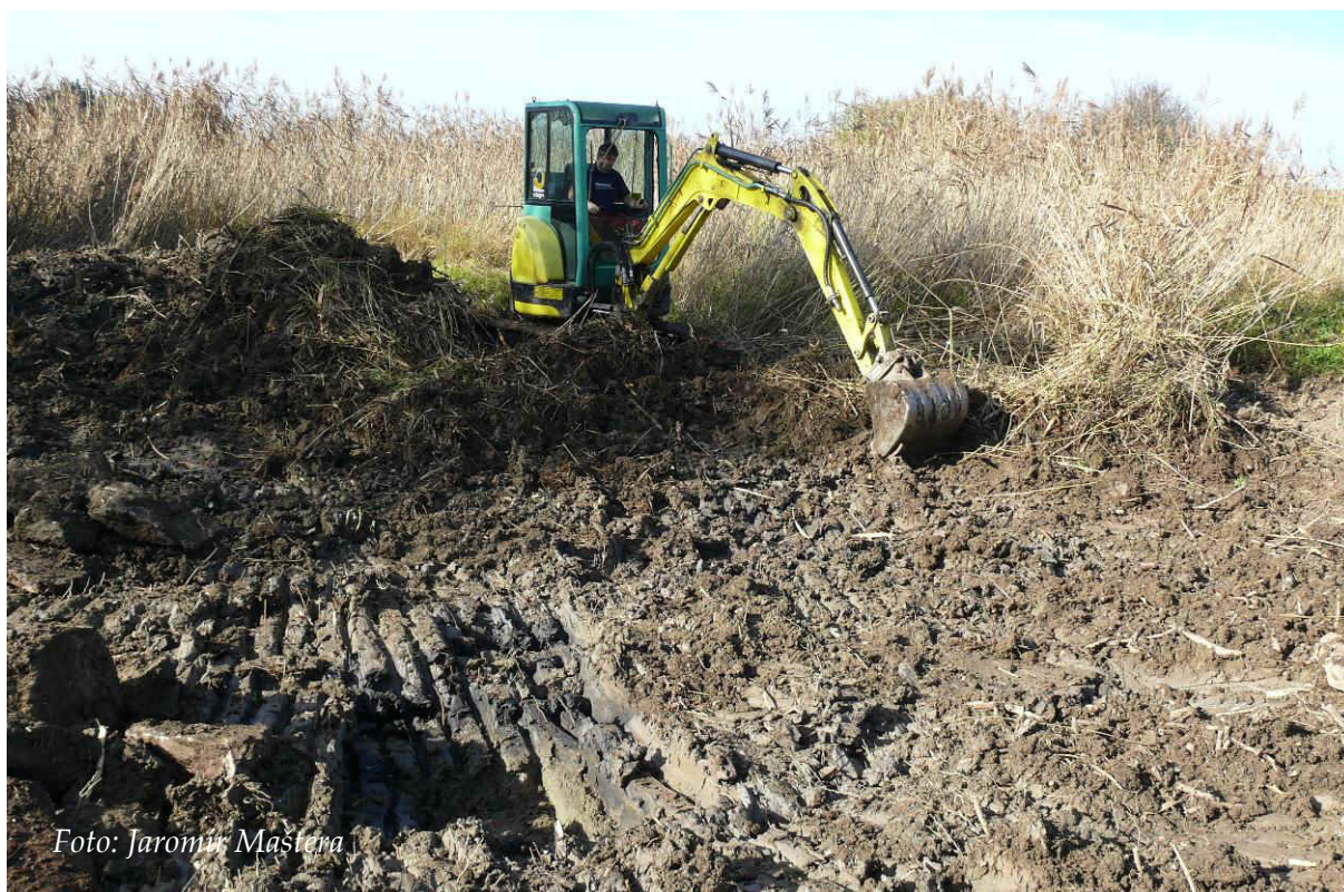
Obr. 22: Hloubení největší mělké tůně pásovým minirypadlem (říjen 2013)
