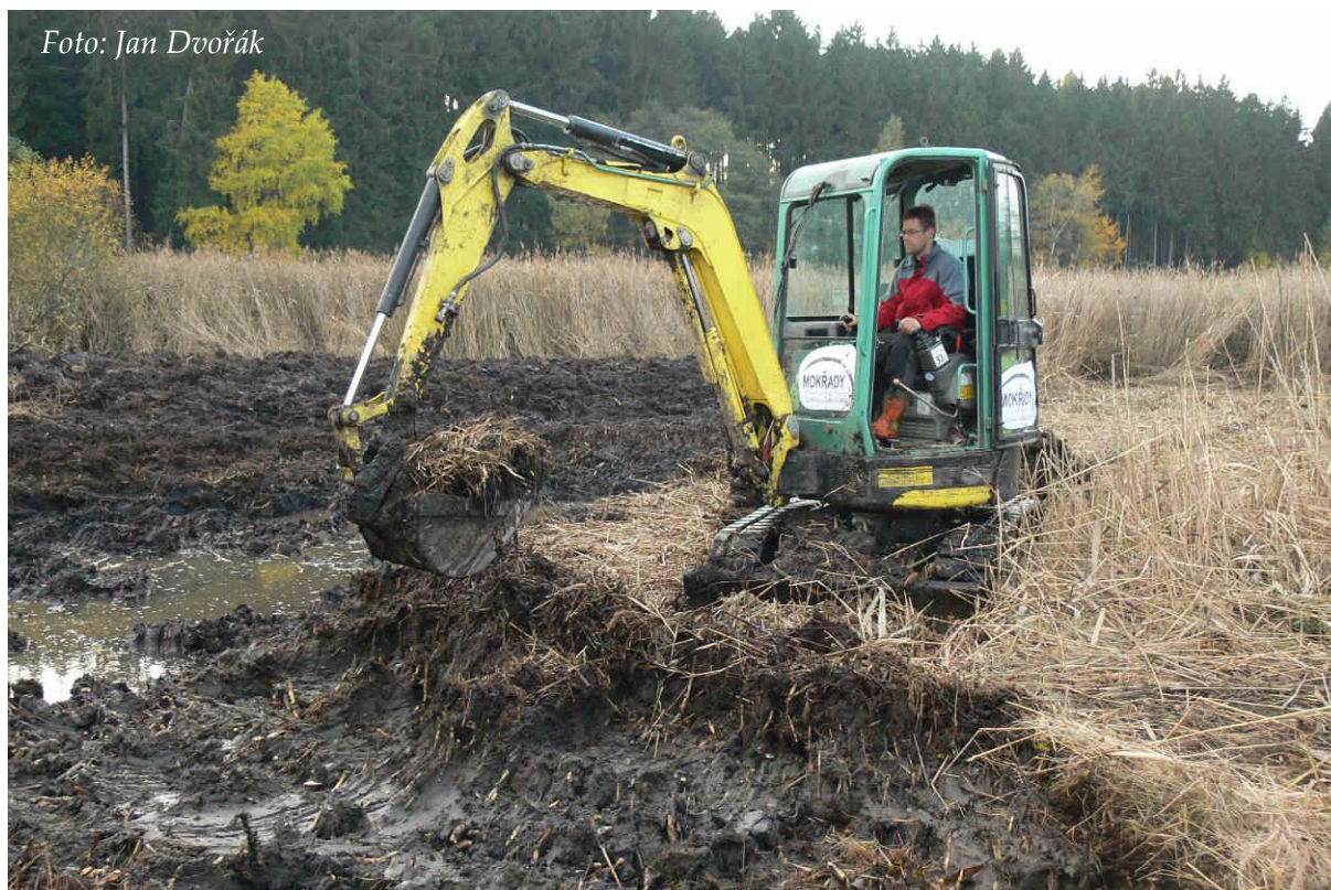
Obr. 26: Strojní hloubení největší z tůní nad Bradlem (listopad 2013)
