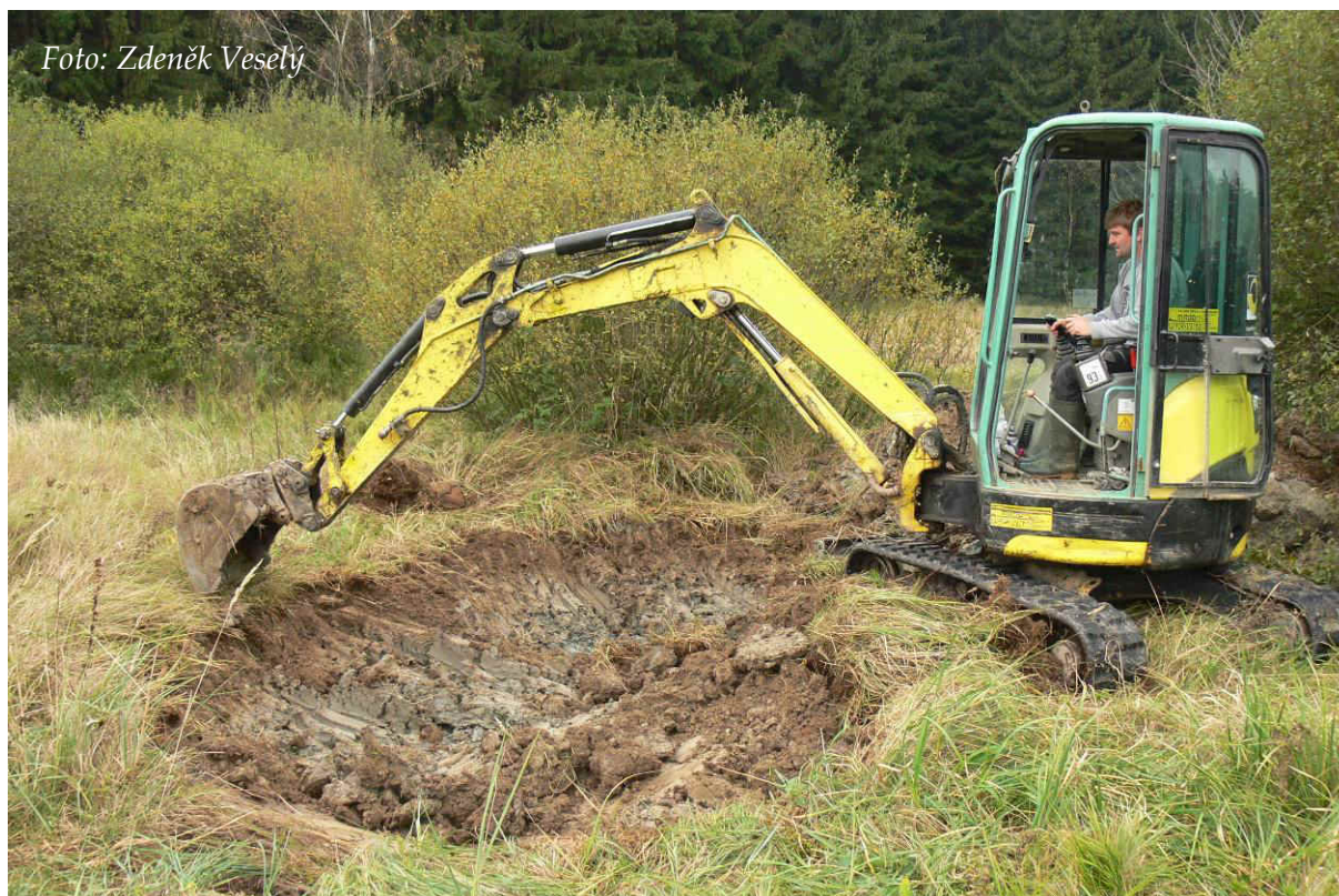
Obr. 26: Hloubení jedné z tůní pod Ochozem pásovým minirypadlem (říjen 2014)
