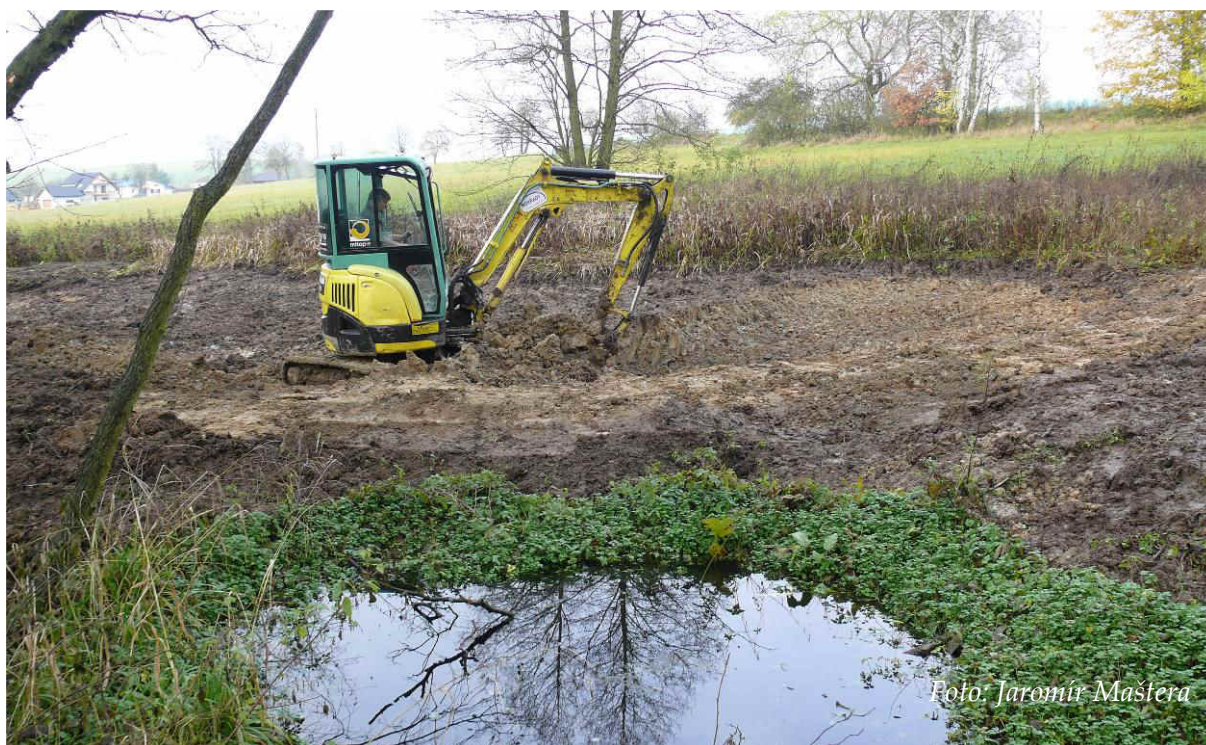
Obr. 35: Budování velké tůně v blízkosti funkční tůně 3 roky staré v lokalitě Na Hádkách (říjen 2014)
