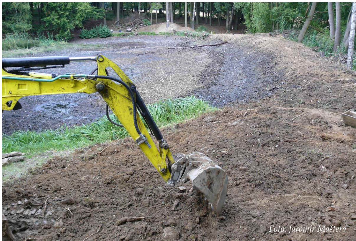
Obr. 34: Oprava hráze rybníka Kulatina pásovým minibagrem (září 2014)
