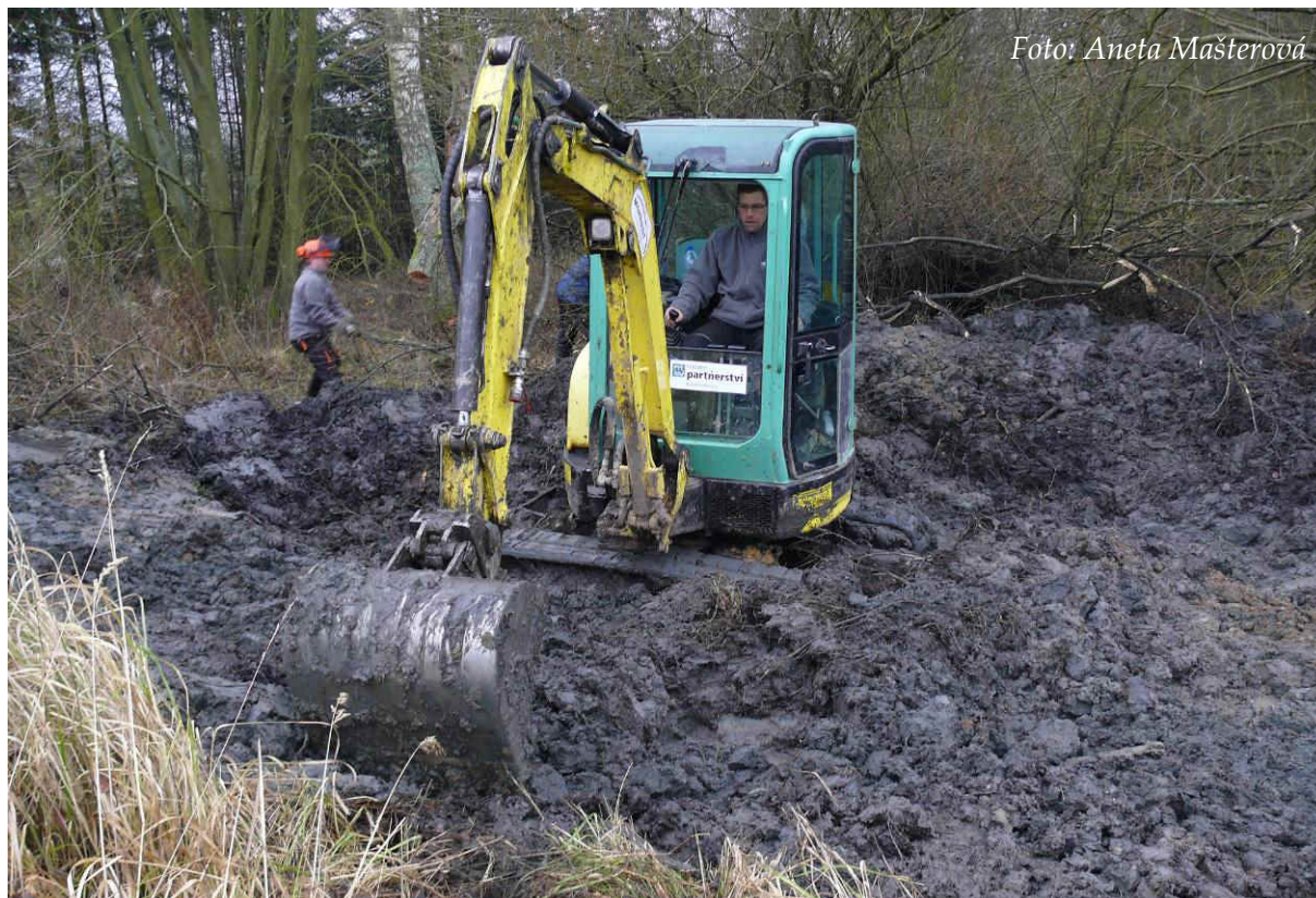
Obr. 18: Prořezávka křovin a budování jedné z nových tůní ve Žlebech (listopad 2014)
