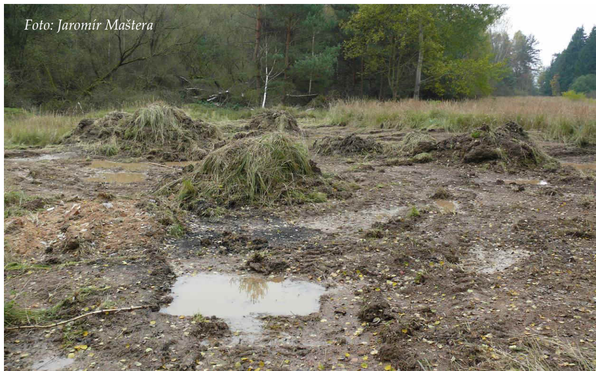
Obr. 31: Úprava povrchu – narušení a stržení drnu – bylo prováděno strojně v části VVP (říjen 2014)
