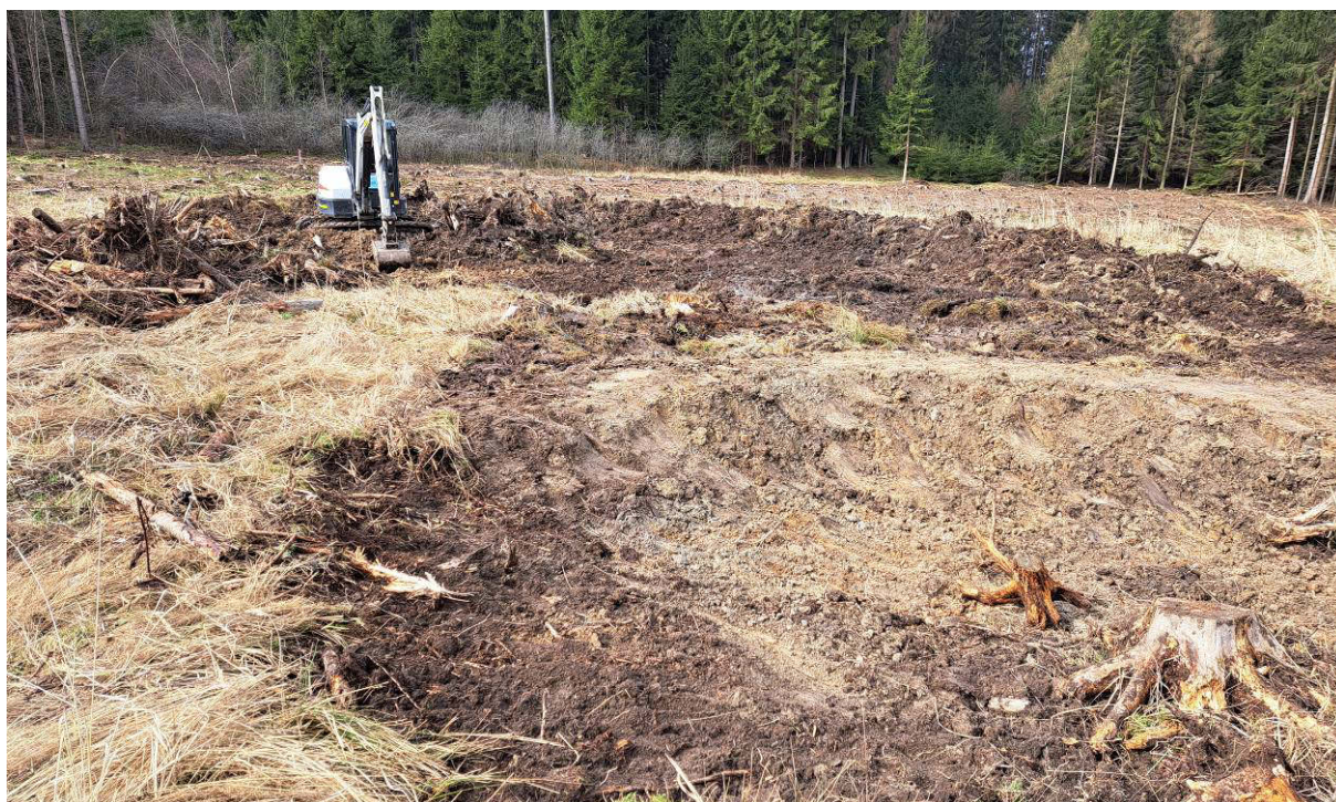
Obr. 23: Hloubení největší tůně u Lukavce a hotová malá tůň v popředí (březen 2023)
