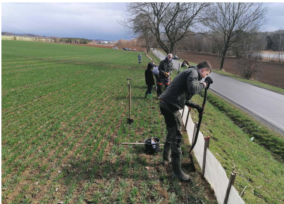
Obr. 1: Budování dočasných zábran u silnice u rybníku Sviták (březen 2023)
