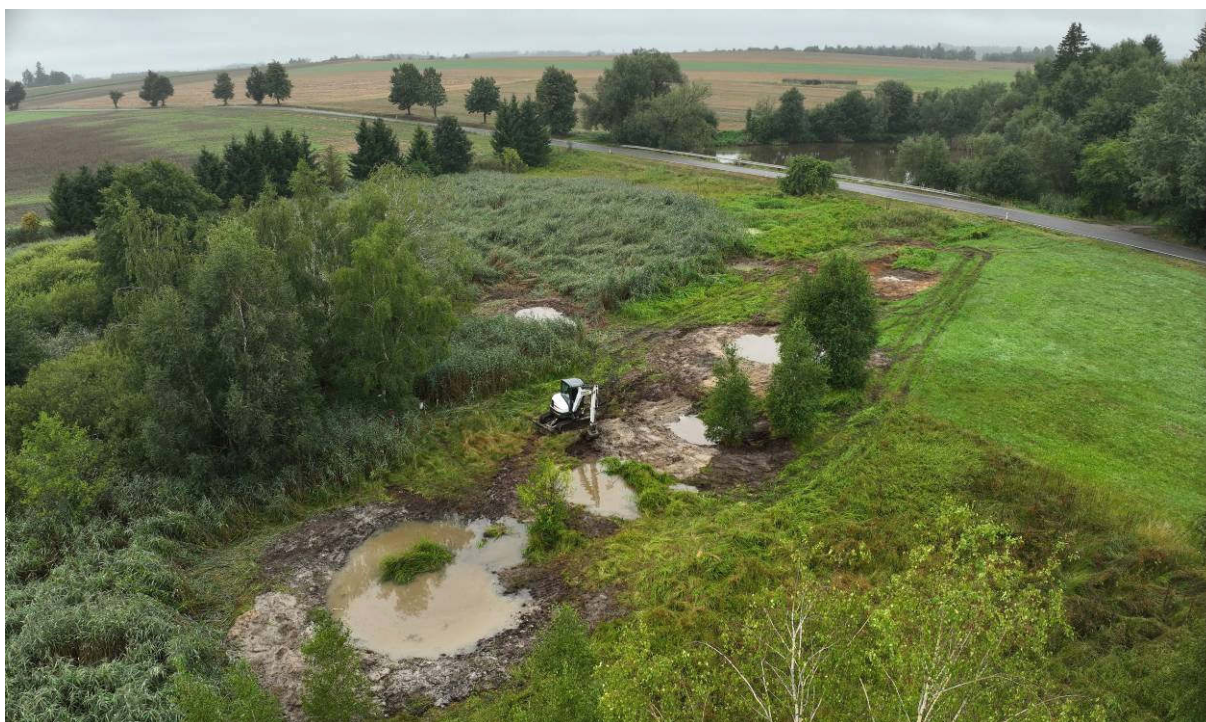
Obr. 34: Strojní hloubení tůní a přehrážek na původním odvodňovacím kanálu u Hruškovce (září 2023)
