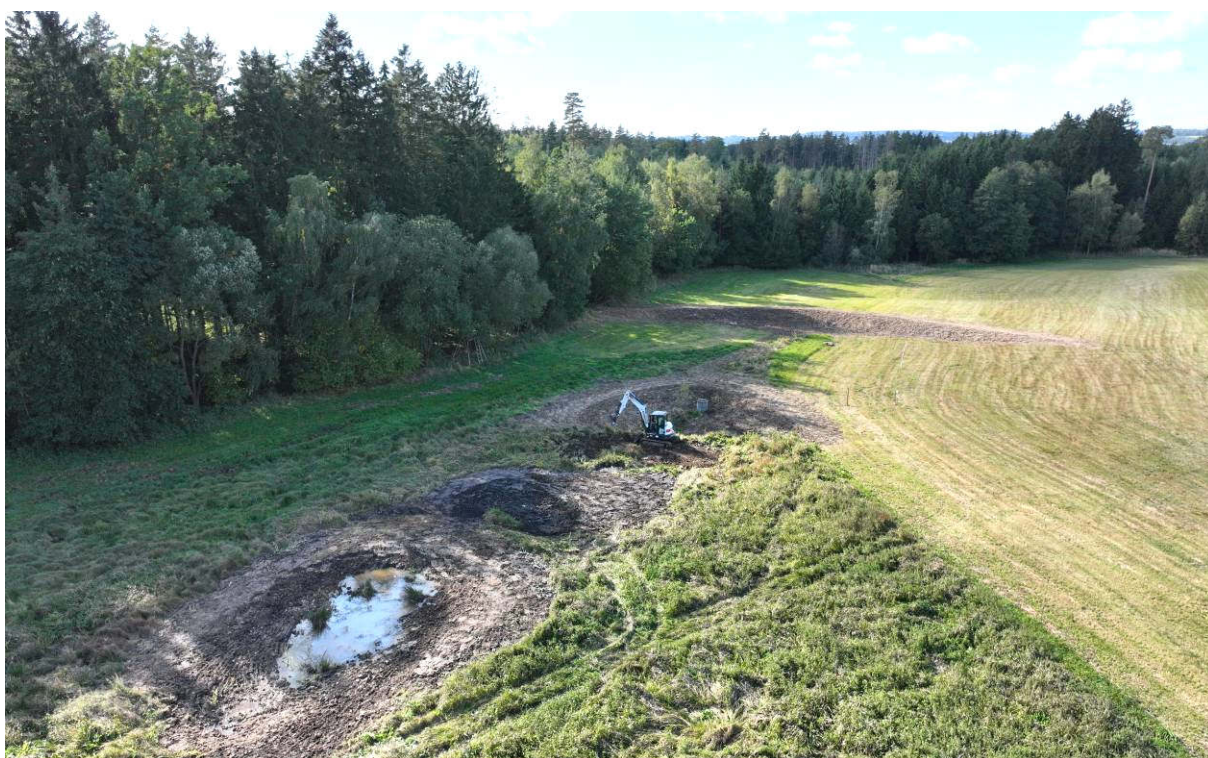
Obr. 58: Práce na menších tůních v lokalitě SZ od Zdešova (říjen 2023)
