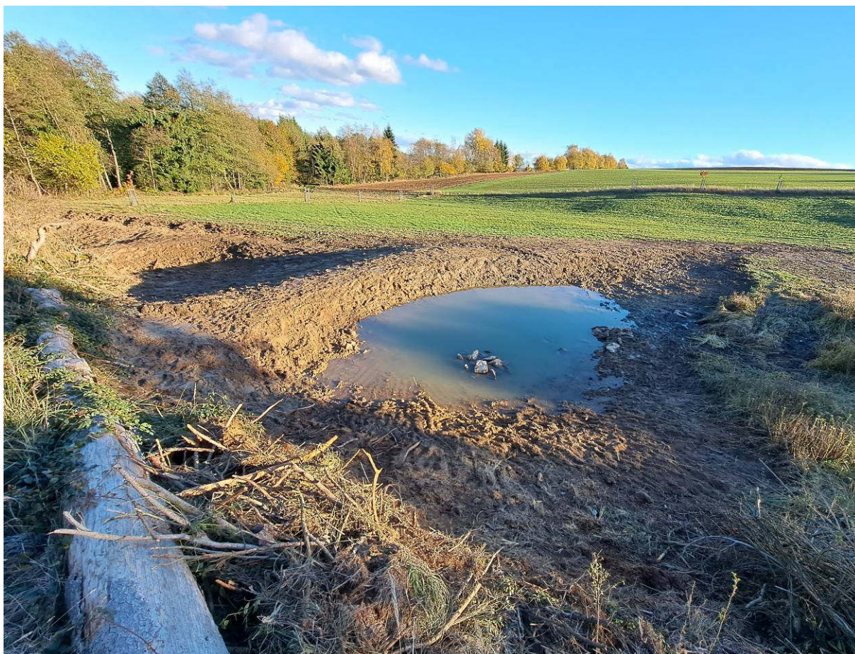
Obr. 67: Čerstvě dokončená realizace tůň a stružky u Albrechtic (listopad 2023)
