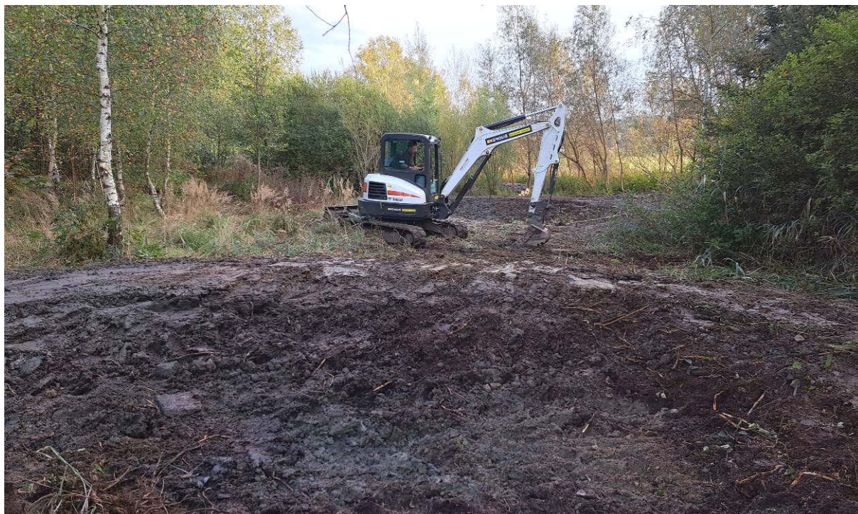
Obr. 35: Finální úpravy terénu u vyhloubených tůní u Ovčina (říjen 2023)
