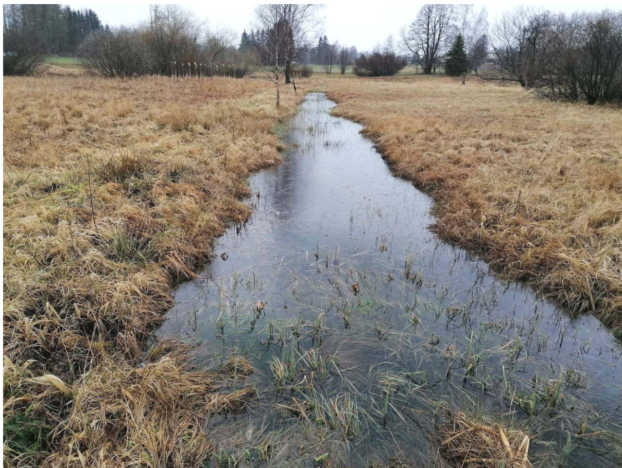
Obr. 81: Kanál na Rašeliništi Kaliště, 3 roky po rozšíření a zpomalení odtoku (březen 2023)
