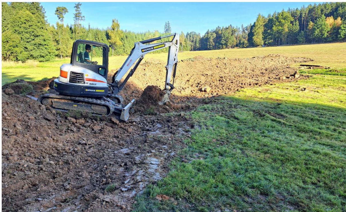
Obr. 57: Tvorba největší tůně v historické vodní ploše s cílem její obnovy (říjen 2023)
