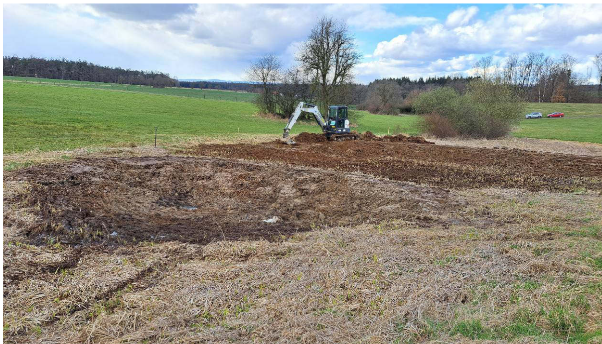
Obr. 25: Hloubení nových tůní v mokřadu u Jetmarského mlýna (září 2023)
