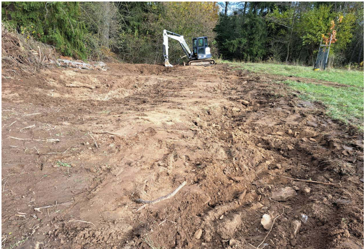
Obr. 38: Modelace odtokové stružky a dalších menších tůní u Albrechtic (listopad 2023)
