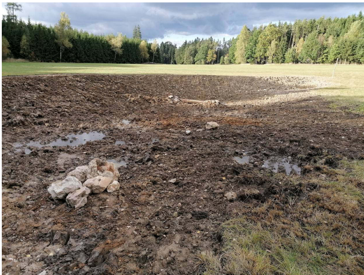
Obr. 69: Největší tůň u Zdešova po vyhloubení a úpravě valu a drenáží (listopad 2023)
