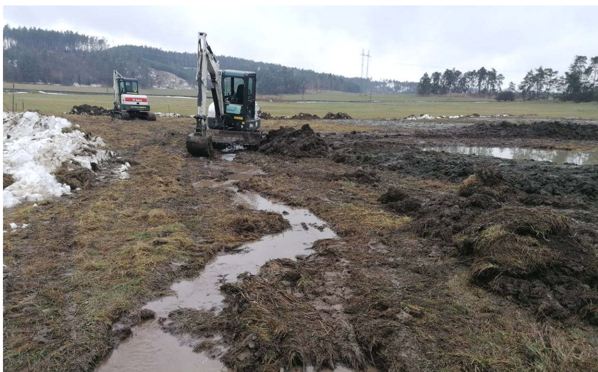
Obr. 32: Modelace odtokové stružky u spodní tůně u Častotického rybníka (prosinec 2023)
