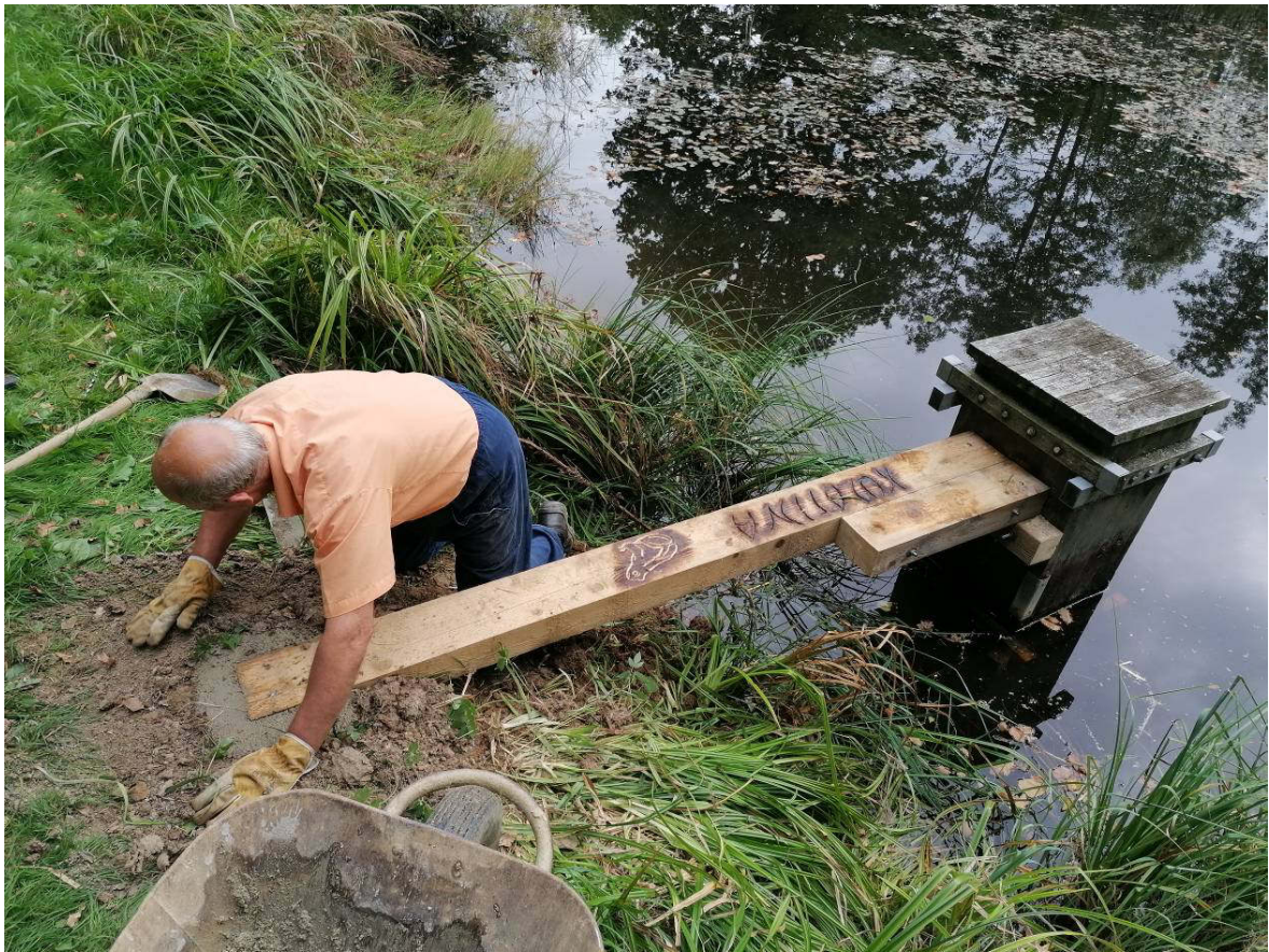
Obr. 19: Osazení nové lávky na rybník Kulatina (říjen 2023)
