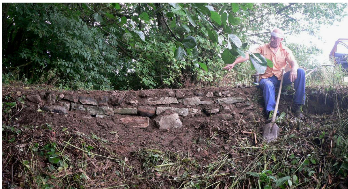
Obr. 36: Opravený mostek u rybníka V Seči dolní (srpen 2023)
