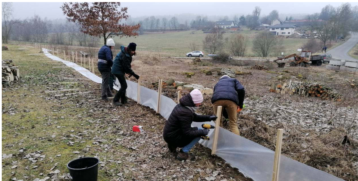
Obr. 2: Stavba dočasných zábran u Obecního rybníka u Hojkova (březen 2024)
