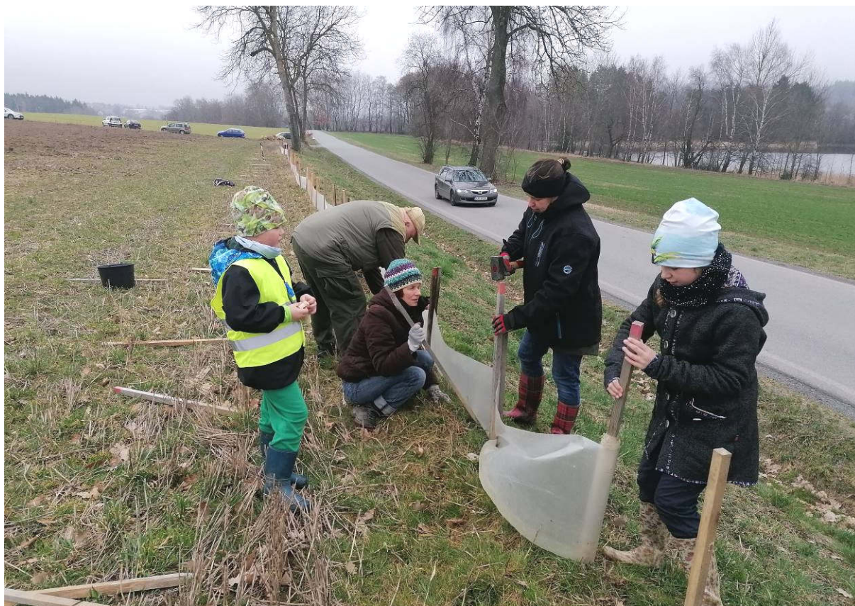
Obr. 1: Stavba dočasných zábran u rybníka Sviták (březen 2024)
