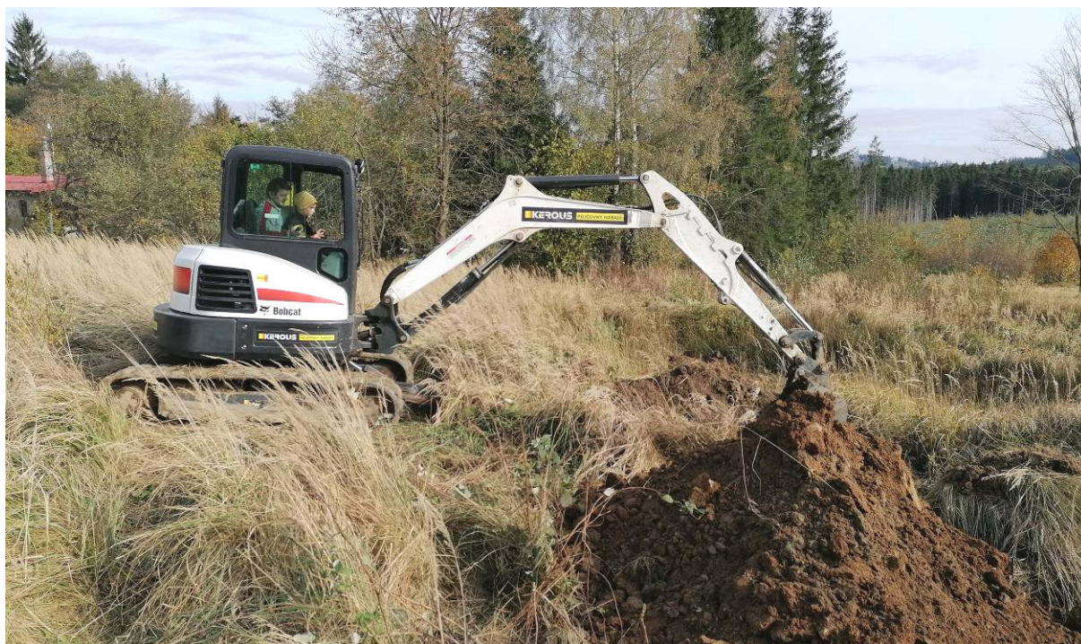
Obr. 20: Obkop s cílem nalezení průsaků u jedné z tůní na Mukařce (říjen 2024)
