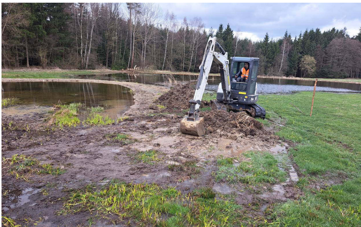
Obr. 40: Oprava poškozeného valu tůně u Zdešova (březen 2024)
