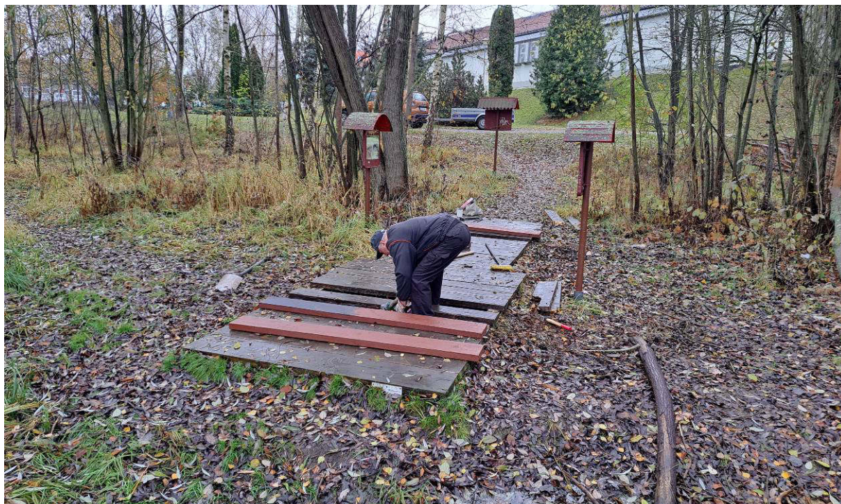
Obr. 36: Oprava poškozených dílů poválkového chodníku na Kalvárii (listopad 2024)
