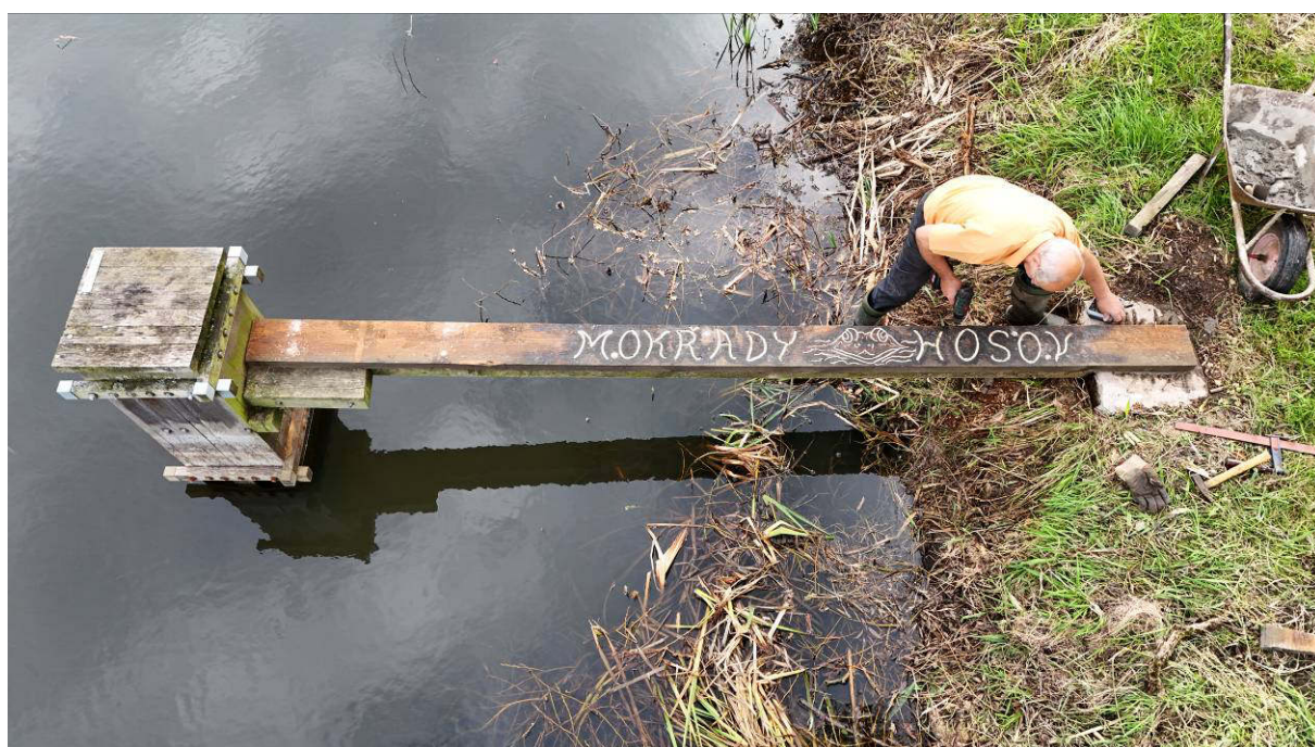
Obr. 31: Oprava lávky u dolního Hosovského rybníčku (říjen 2025)
