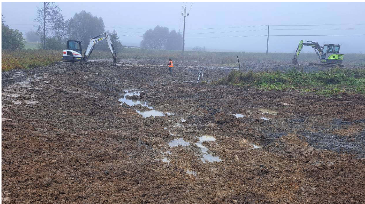
Obr. 56: Dokončování tůní pod Otínem (říjen 2025)
