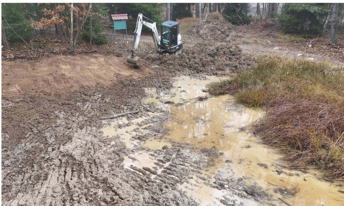
Obr. 23: Stržení drnu v bývalé pískovně Hulišťata (listopad 2025)
