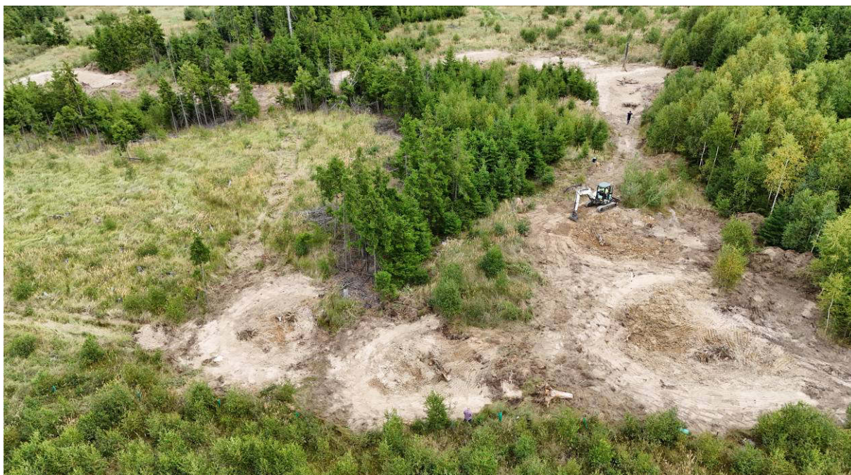
Obr. 39: Dokončování soustavy lesních tůní u Henčova (srpen 2025)
