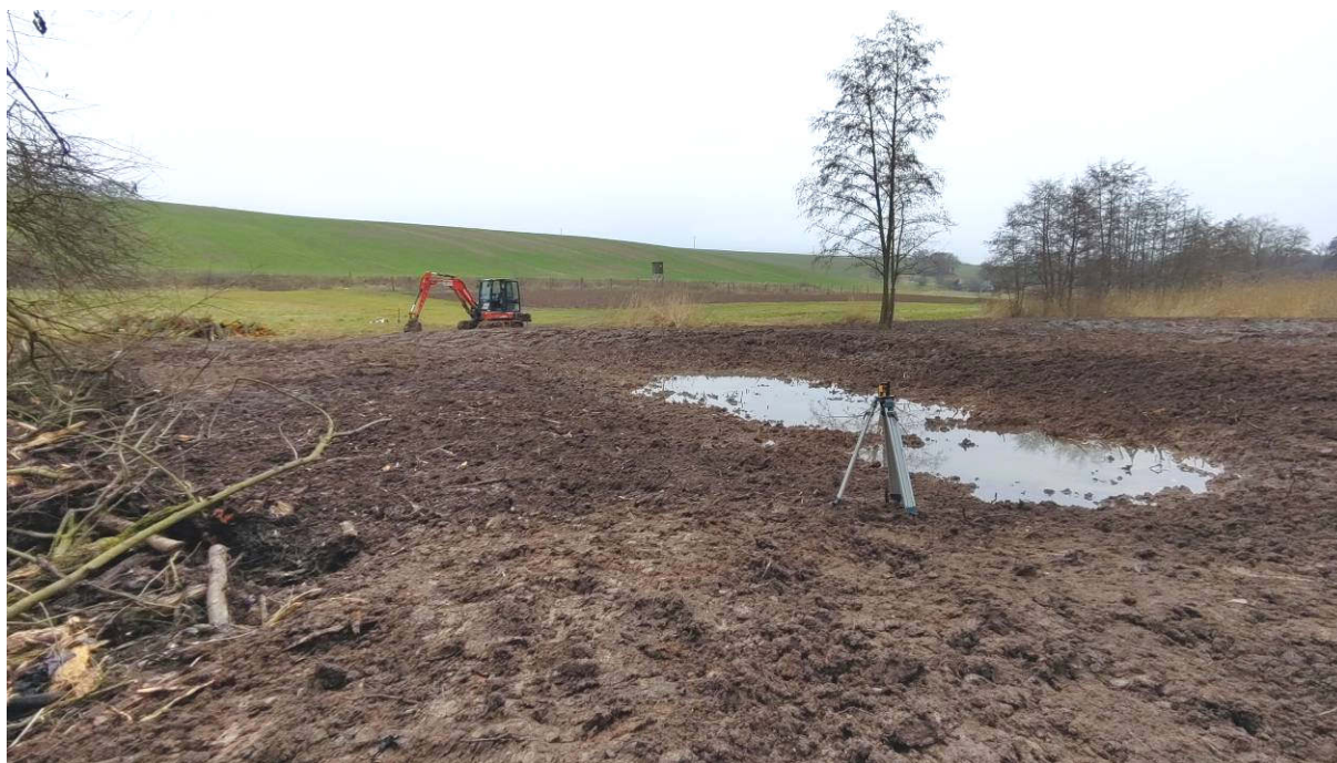
Obr. 36: Dokončování prací v lokalitě pod Spáleným rybníkem (prosinec 2025)
