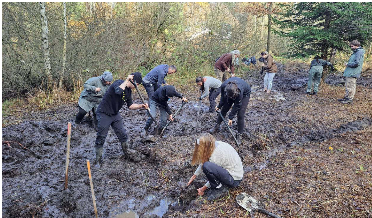
Obr. 54: Dobrovolníci vyřazují z funkce odvodňovací kanál a tvoří tůňku (listopad 2025)
