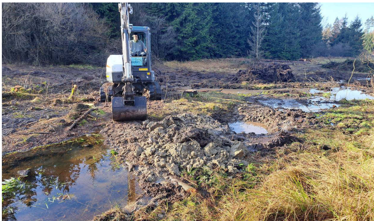
Obr. 55: Doplňování jílové přehrážky na odvodňovacím kanálu pod prameništěm (prosinec 2025)
