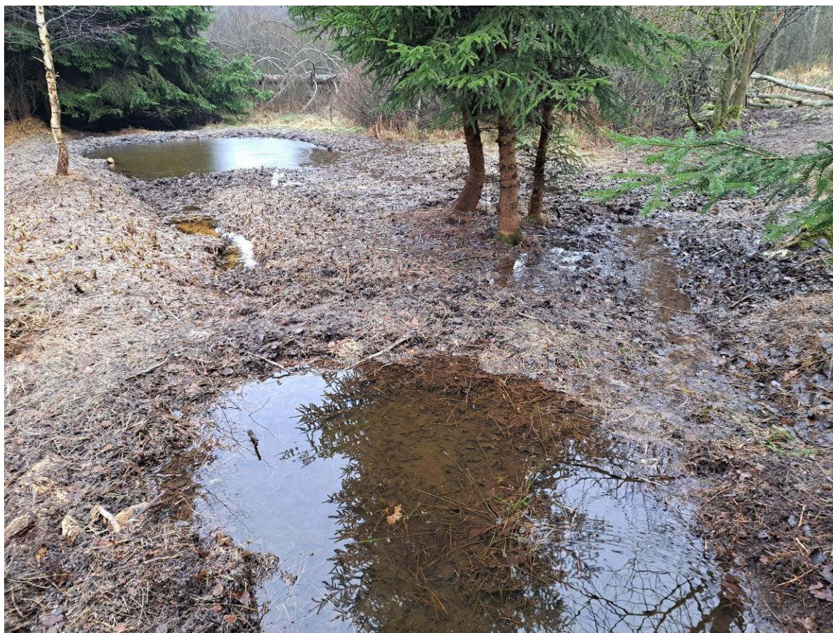
Obr. 88: Tůňky na kanálu a odklon odtoku do strany – ruční revitalizace na Skřivánku (prosinec 2025)
